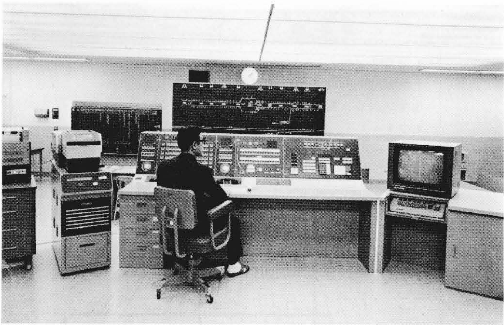
図5 地下鉄運行管理システムの運転指令室 営団有楽町線のHIDIC 350による運行管理システムをつかさどる運転指令室を示す。
