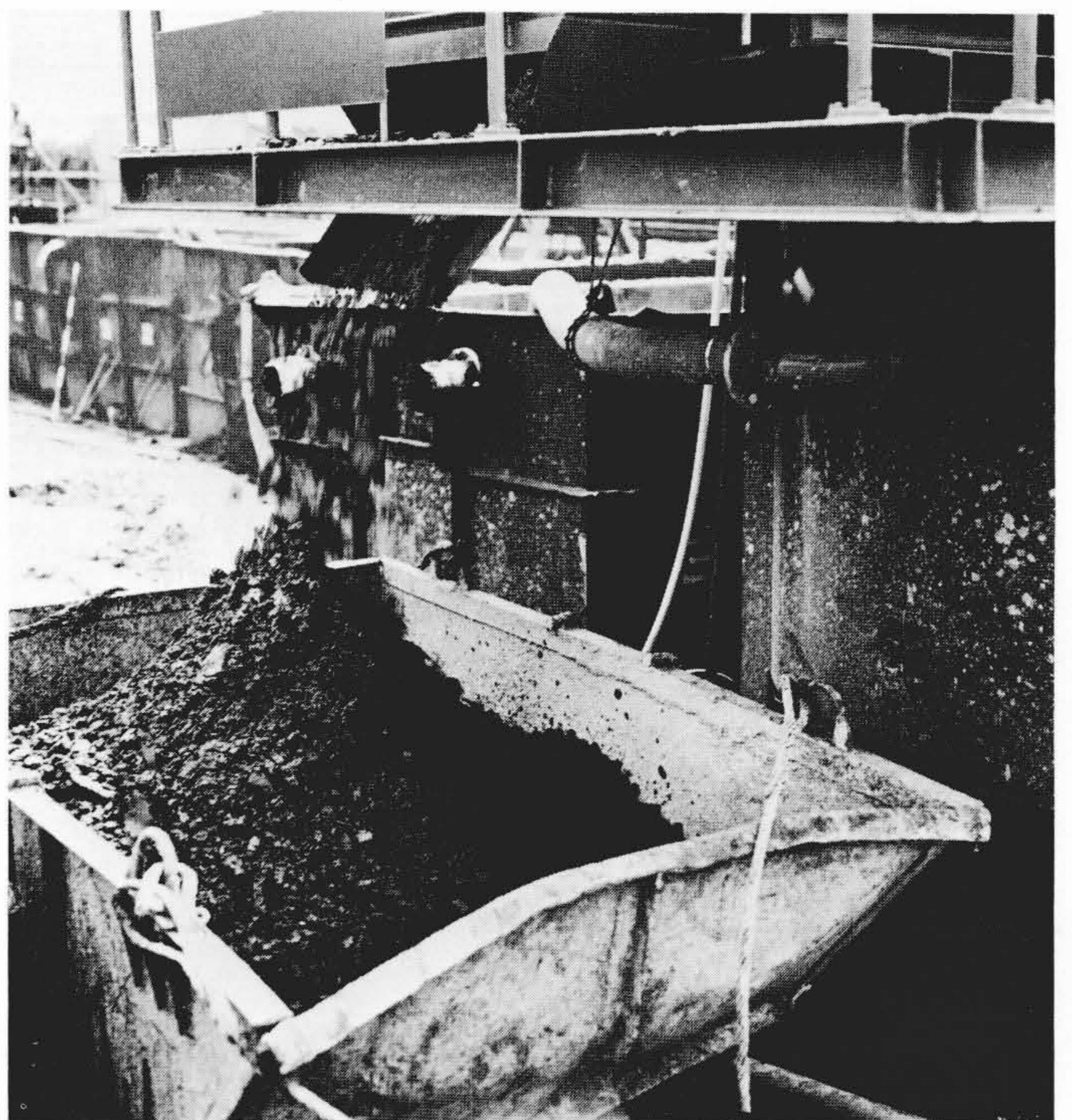
図13 排土の状況 排土の状態は良好で、トラック運搬は容易である。
