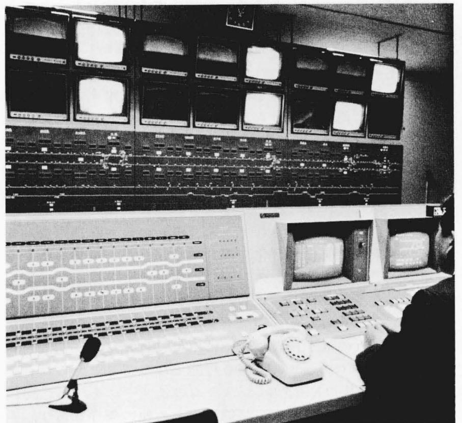
図4 札幌市交通局東西線運転指令室 運転指令員は平常時、駅モニター、テレビジョン、運行監視盤などにより列車運行を確認すればよい。
