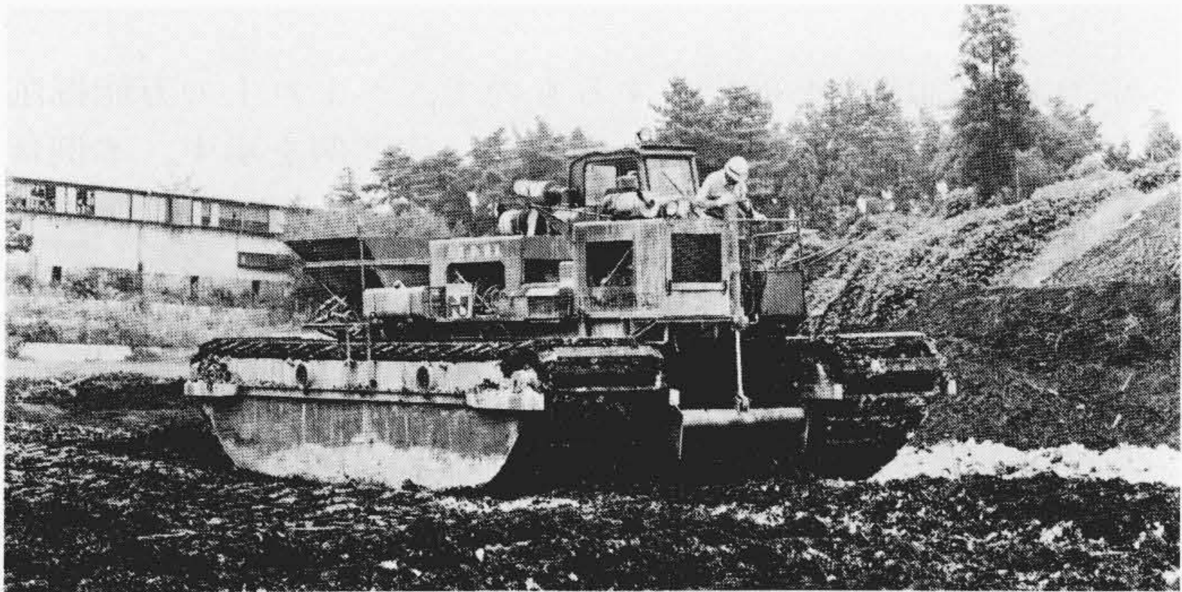
図5 宅地造成地で稼動するMA100H 石灰を散布し、混合攪拌する。
