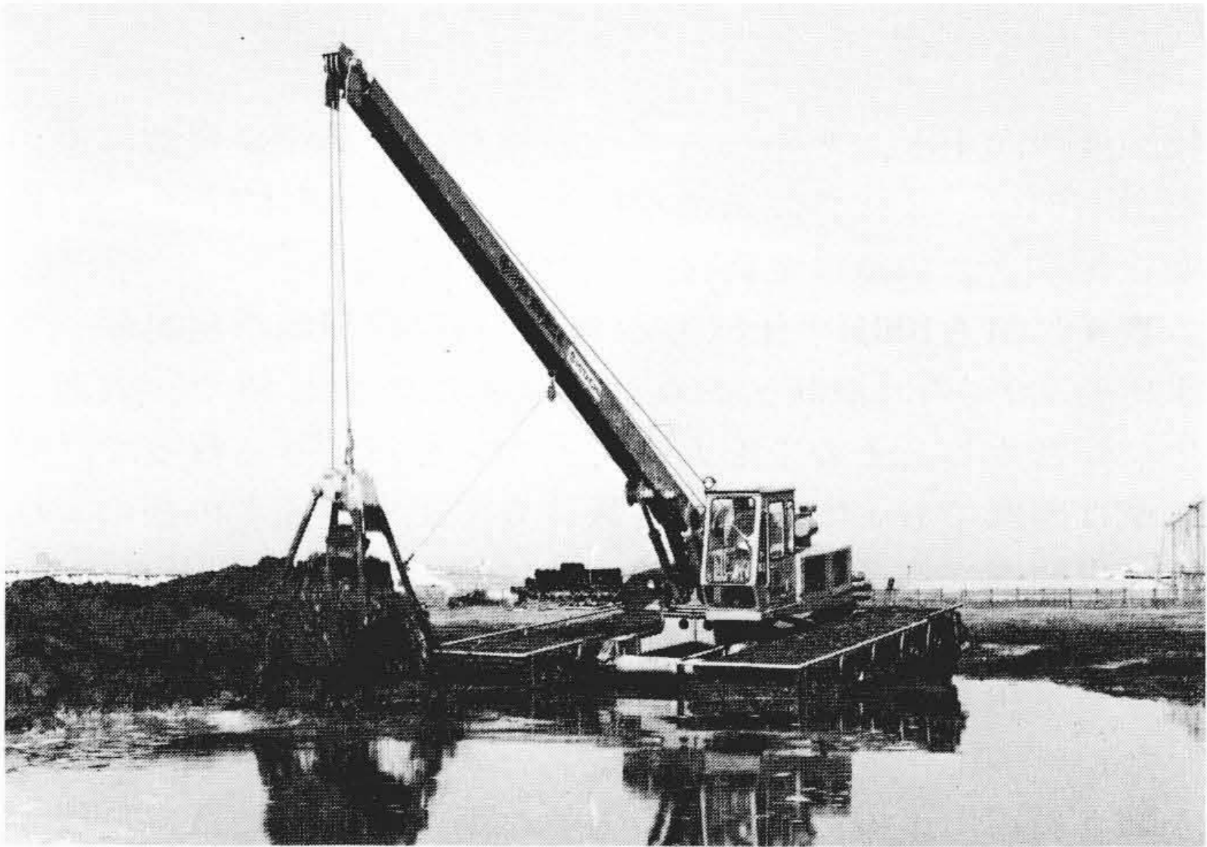
図6 MA100U作業例 写真に示すような埋立地では、通常の建設機械の使用は不可能だけでなく、人の歩行をも困難な場合があり、MA100Uは必須機械となろう。
