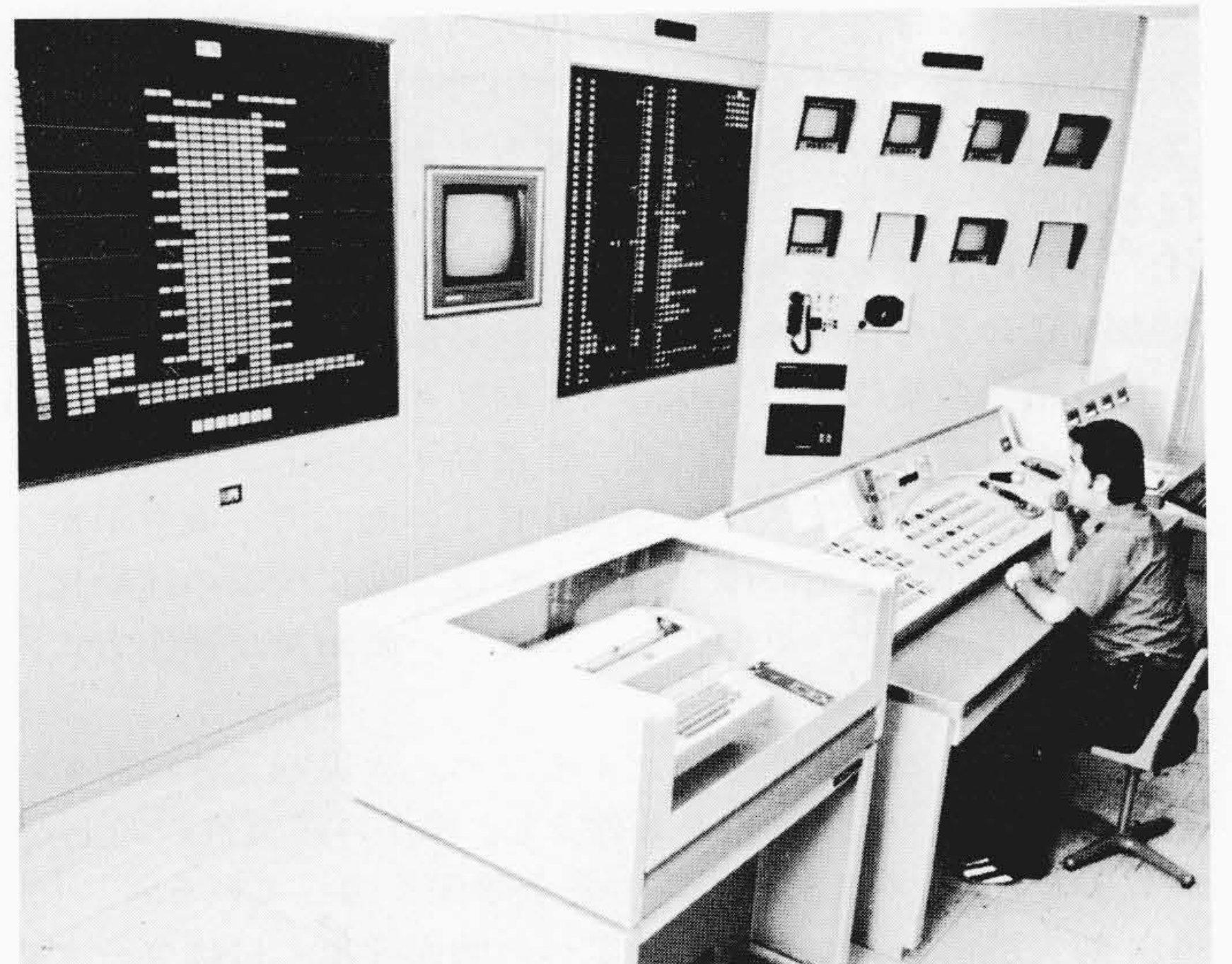
図3 防災監視制御装置の例 KDDビル納めの防災監視制御盤を示す。
