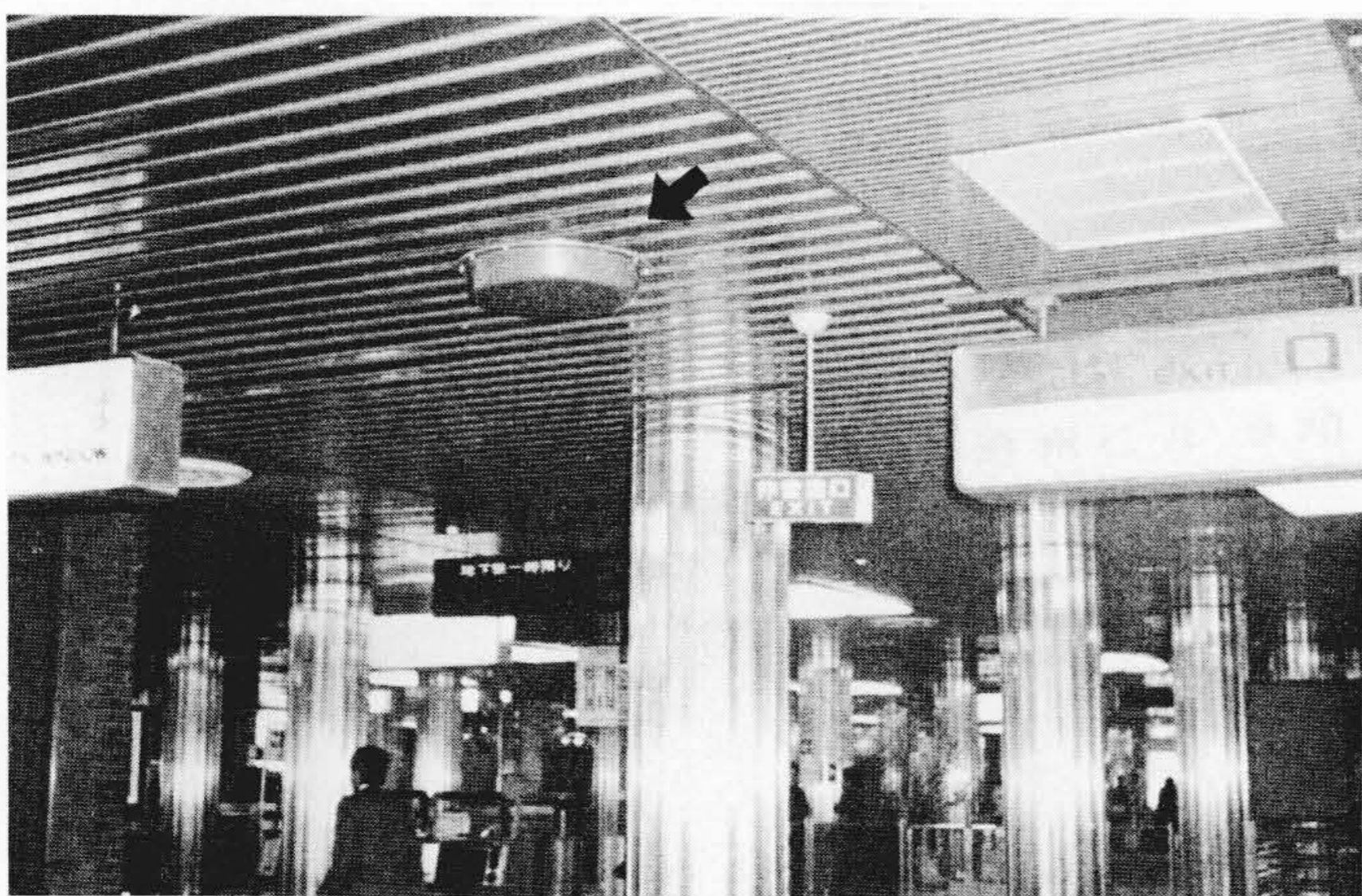
図9 耐熱薄形空中線 金属天井部に空中線を取り付けた状況を示す。
