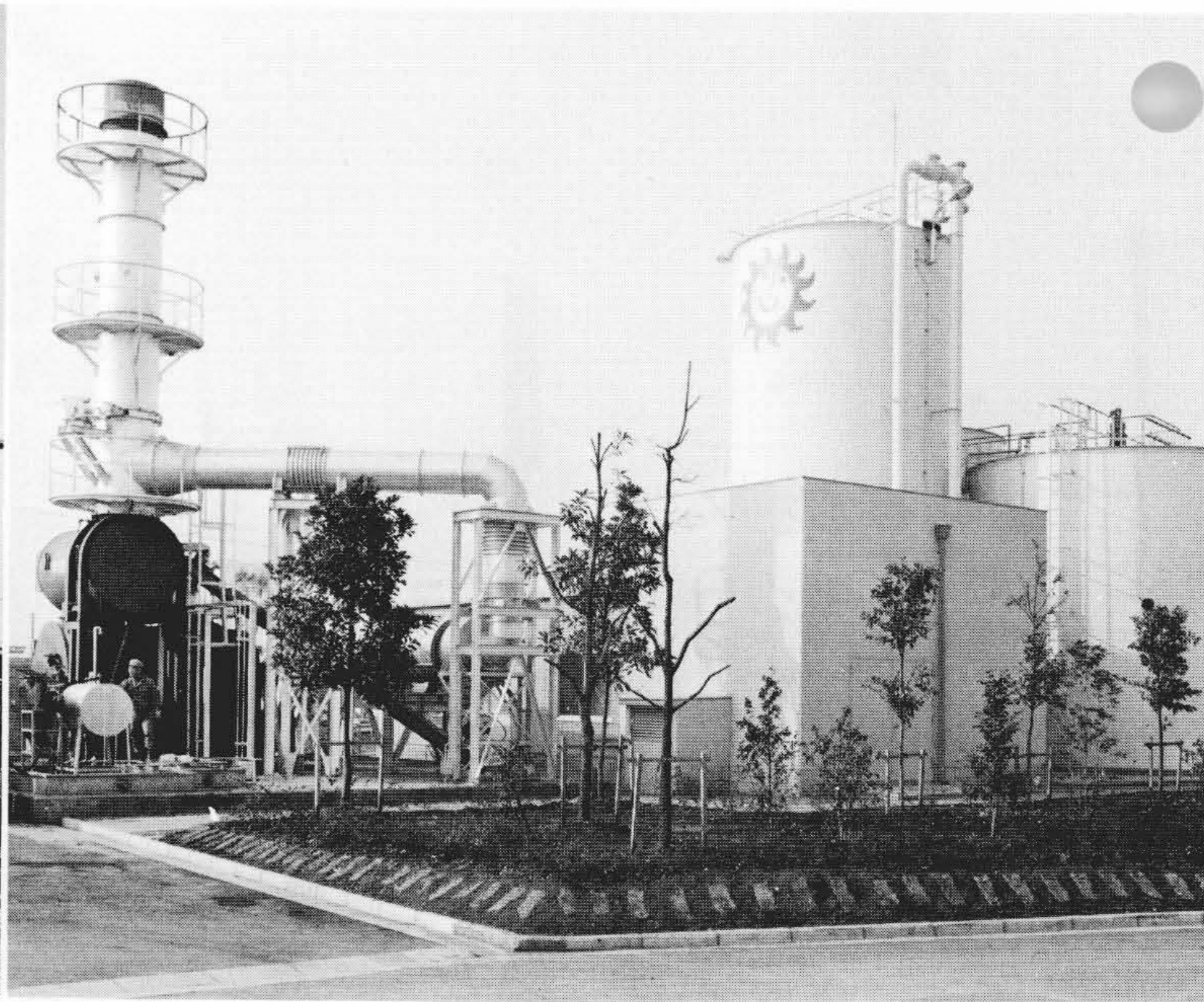
図5 山崎製パン株式会社古河工場納め350m 3 /d製餡廃水処理装置
