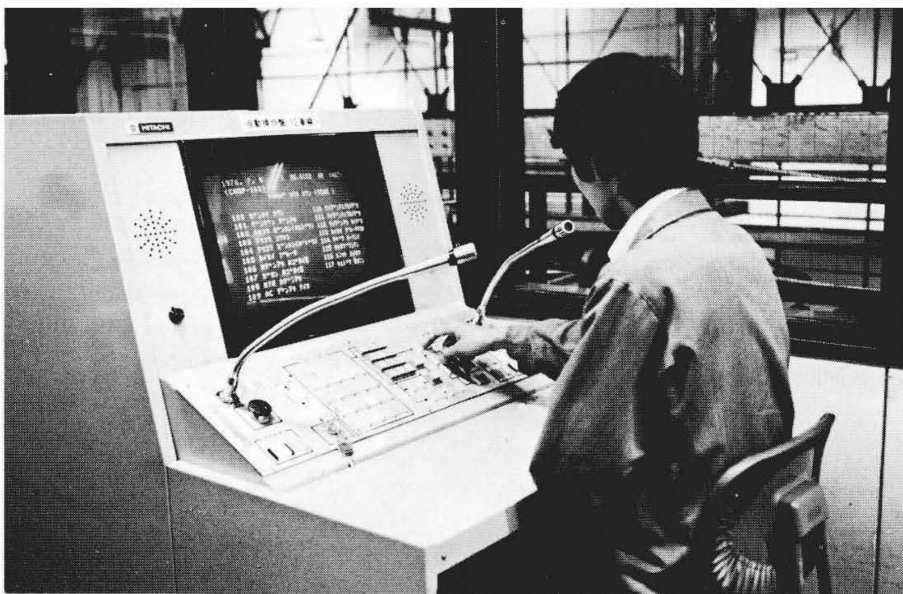
図6 自動試験操作盤(札幌市 交通局東西線高速電車)
