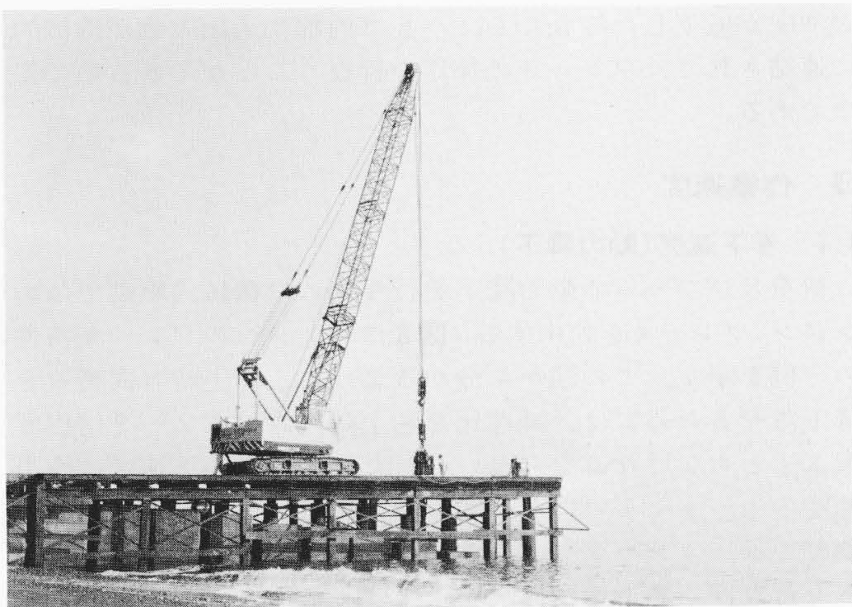
図2 KHI150クローラ クレーン 護岸工事で活躍するKHI150クローラ クレーンを示す。
