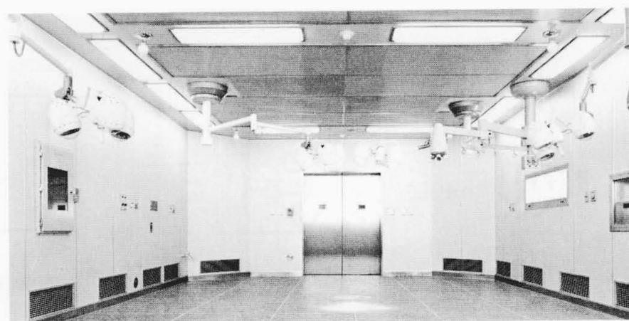
図4 バイオクリーンルーム(手術室)室内 天井面から床に向けて、無菌清浄空気が流れる。無影灯は伸縮アームに取り付けられ天井からの空気の流れを乱さない形状となっている。
