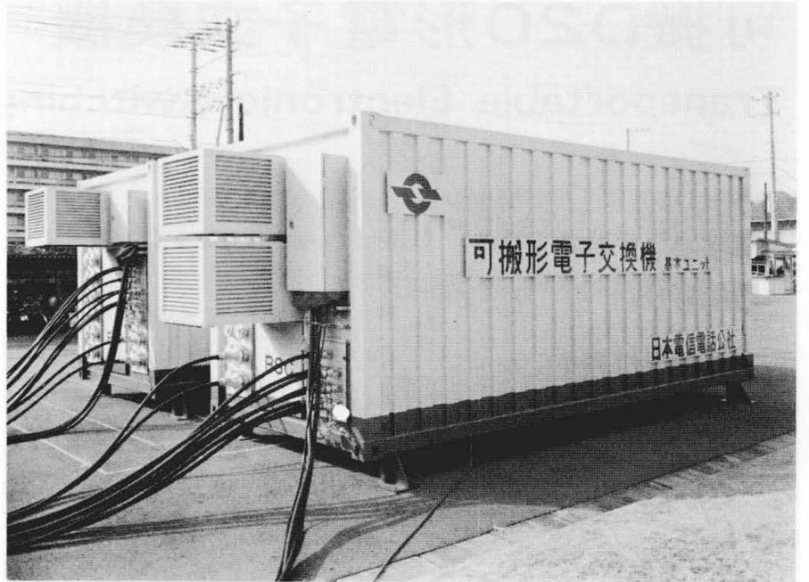
図3 交換装置設置状態 交換装置にコネクタ付ケーブルの一部を接続した状態を示す。
