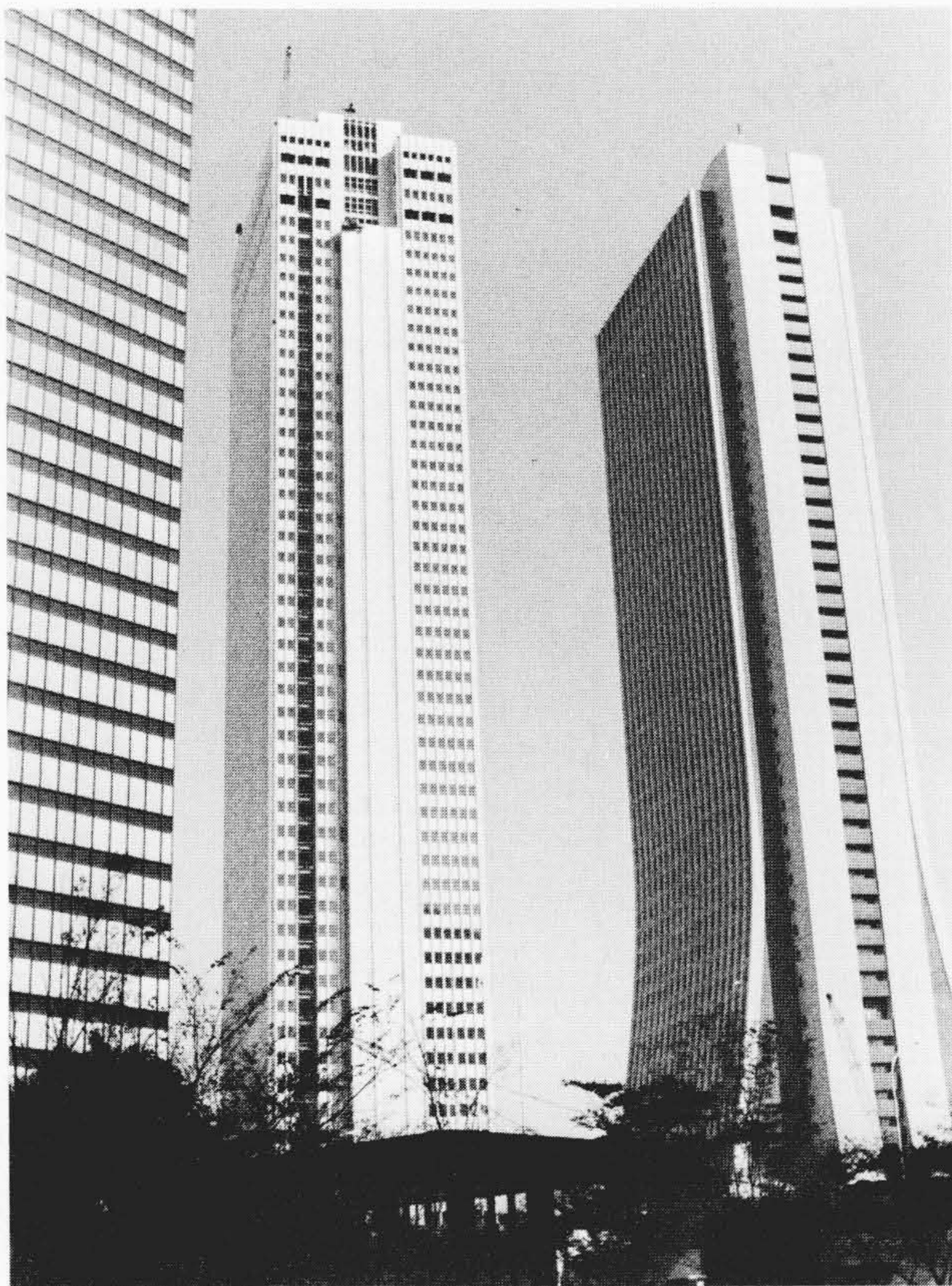
図10 540m/min超高速エレベーターを納入した新宿野村ビル
