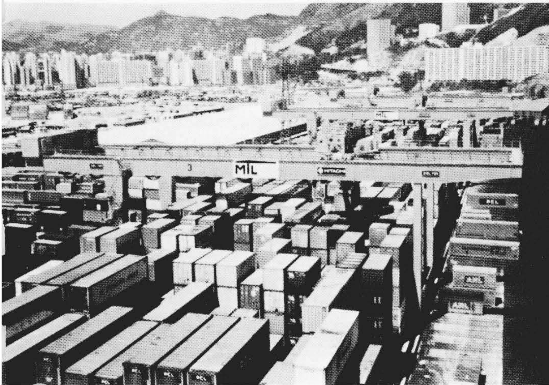
図15 現地で活躍中のトランスファクレーン
