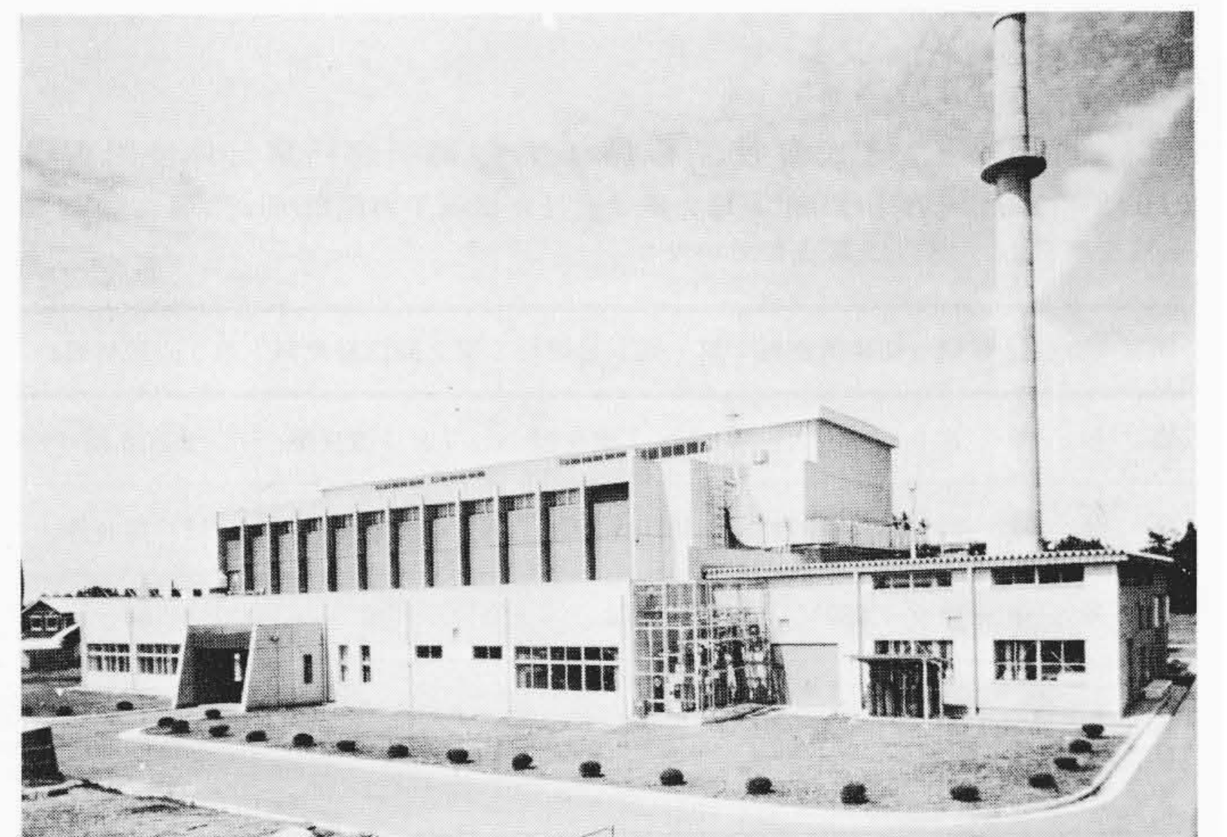
図10 NFDホットラボの外観 ホットラボ正面右よりの鳥観図を示す。照射材は、キャスクとともに建屋の右部から搬入される。
