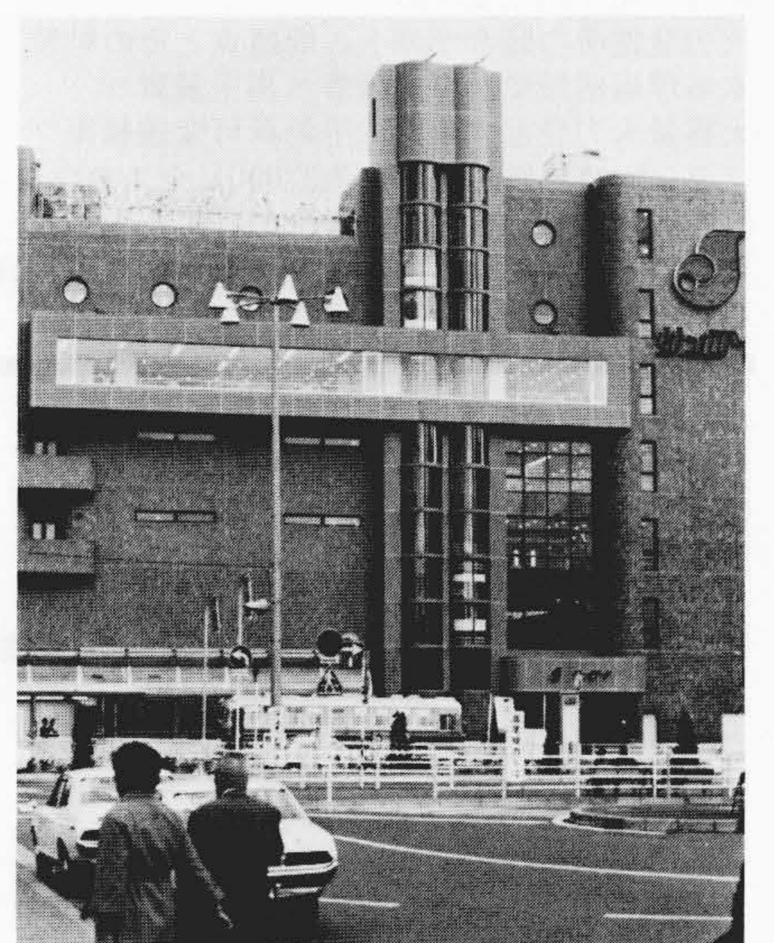
図1 日立展望用エレベーターを設置したビルの外観
