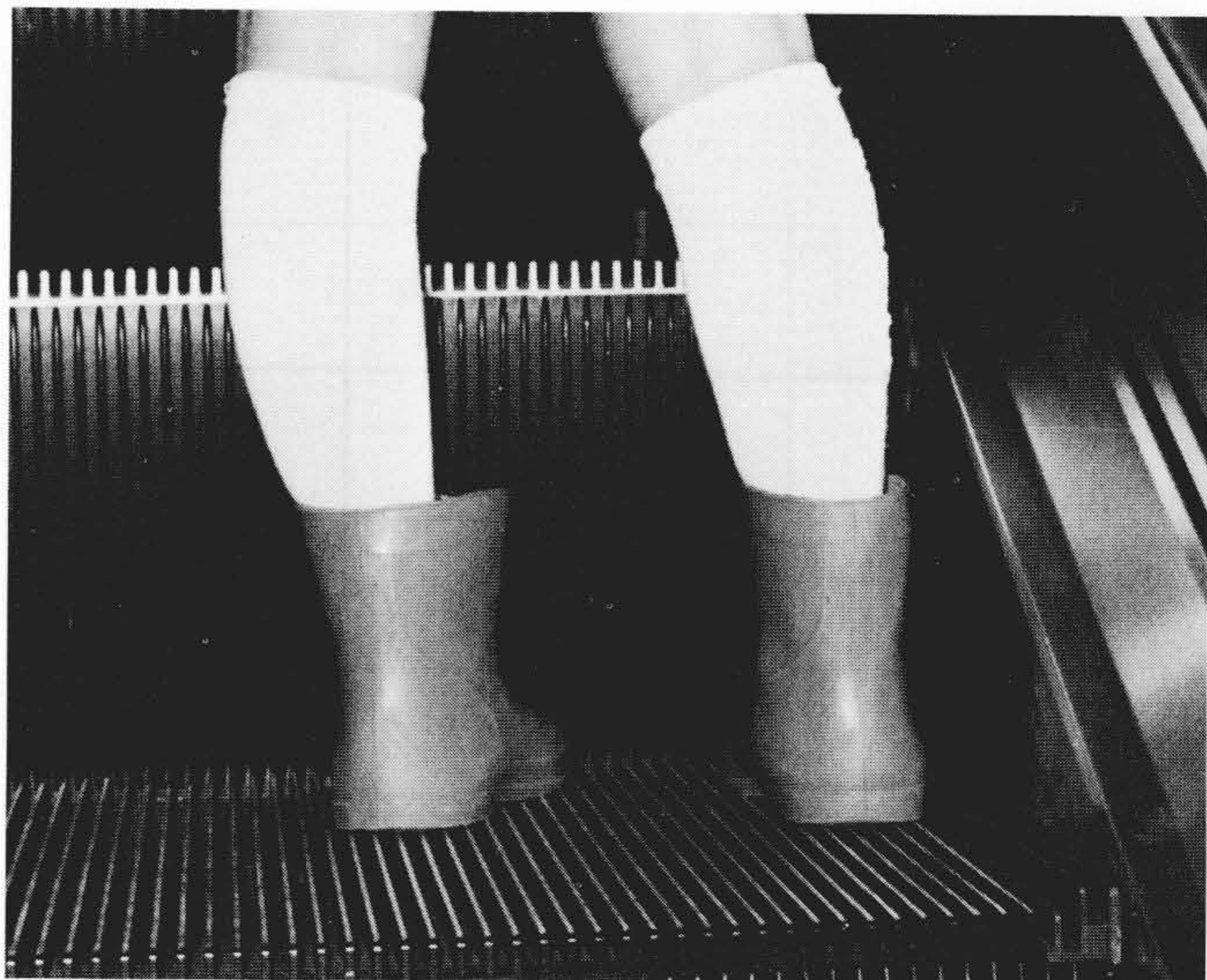
図11 安全増エスカレーターのステップ 三方にデマケーションピースを設け、特に両側端は棧を高くして安全性を著しく高めている。
