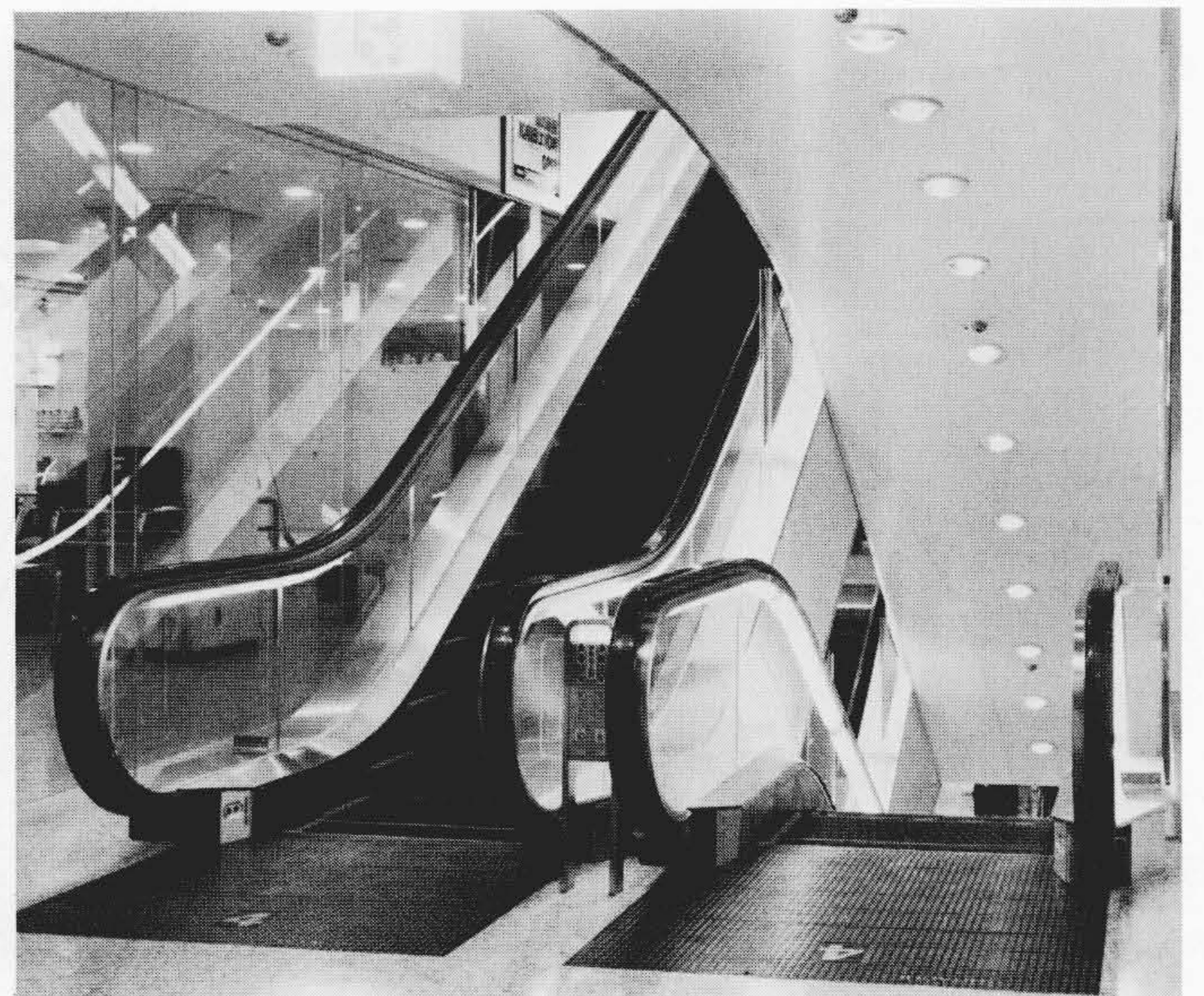
図4 ステンレス欄干エスカレーターの外観 建築意匠品として、全体に高級な雰囲気を与えたエスカレーターを目指している。
