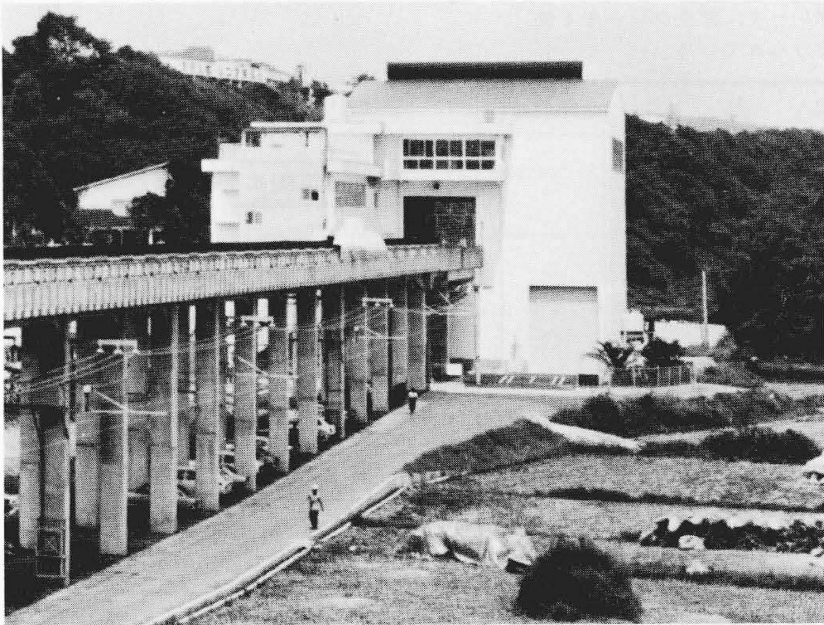
図3 宮崎浮上式鉄道実験センター全景 浮上体は、実験センターから遠隔制御される。
