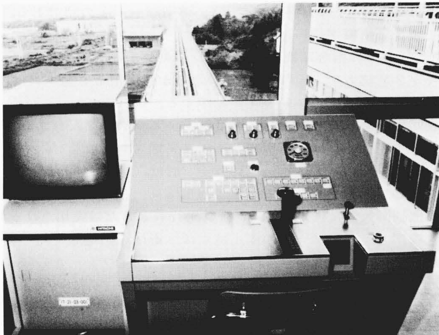
図4 中央制御装置操作盤A 運転制御に必要最小限の機能を備えている。前方の軌道を見渡すことができるよう、パネル面の傾斜を大きくとり全高を低くした。
