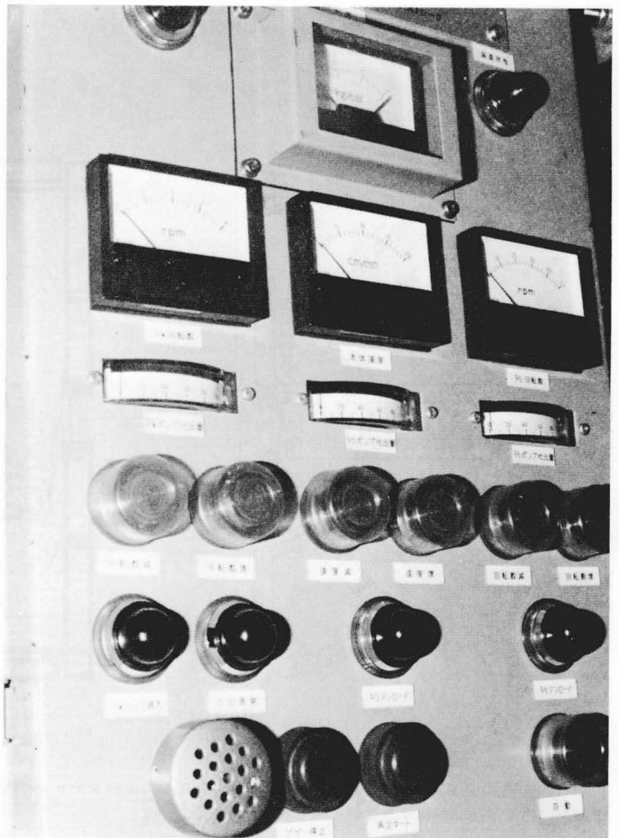
図3 “HIRAC-S”システムの操作盤面 このパネルと近くに設けられた方向切換弁の操作とにより、すべての操作が可能である。“HIRAC-F”に比べて表示される計器は少なくなっている。
