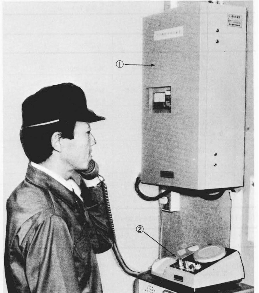
図10 地区基地局装置 実際の操作は司令卓②で行なうため、本体装置①から離れた場所に設置することができる。
