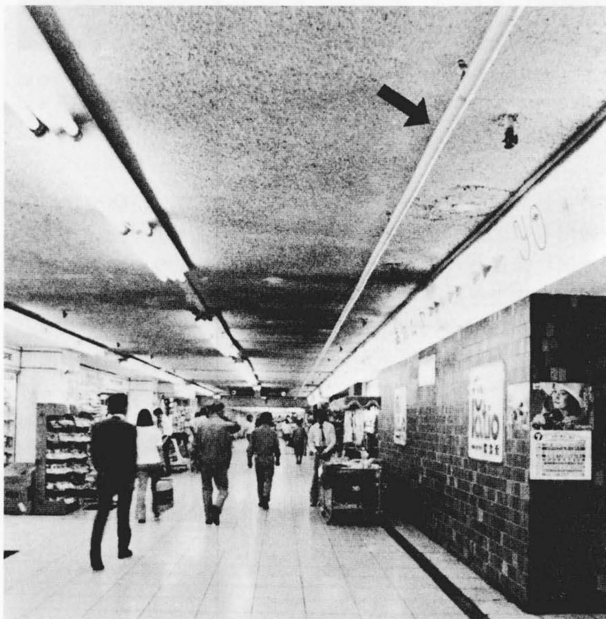
図4 LCX布設例(露出布設) 地下街のLCX回線網は美観を考慮して、一般に天井裏に布設されるが、場所によっては露出布設や薄形アンテナなどが用いられる。
