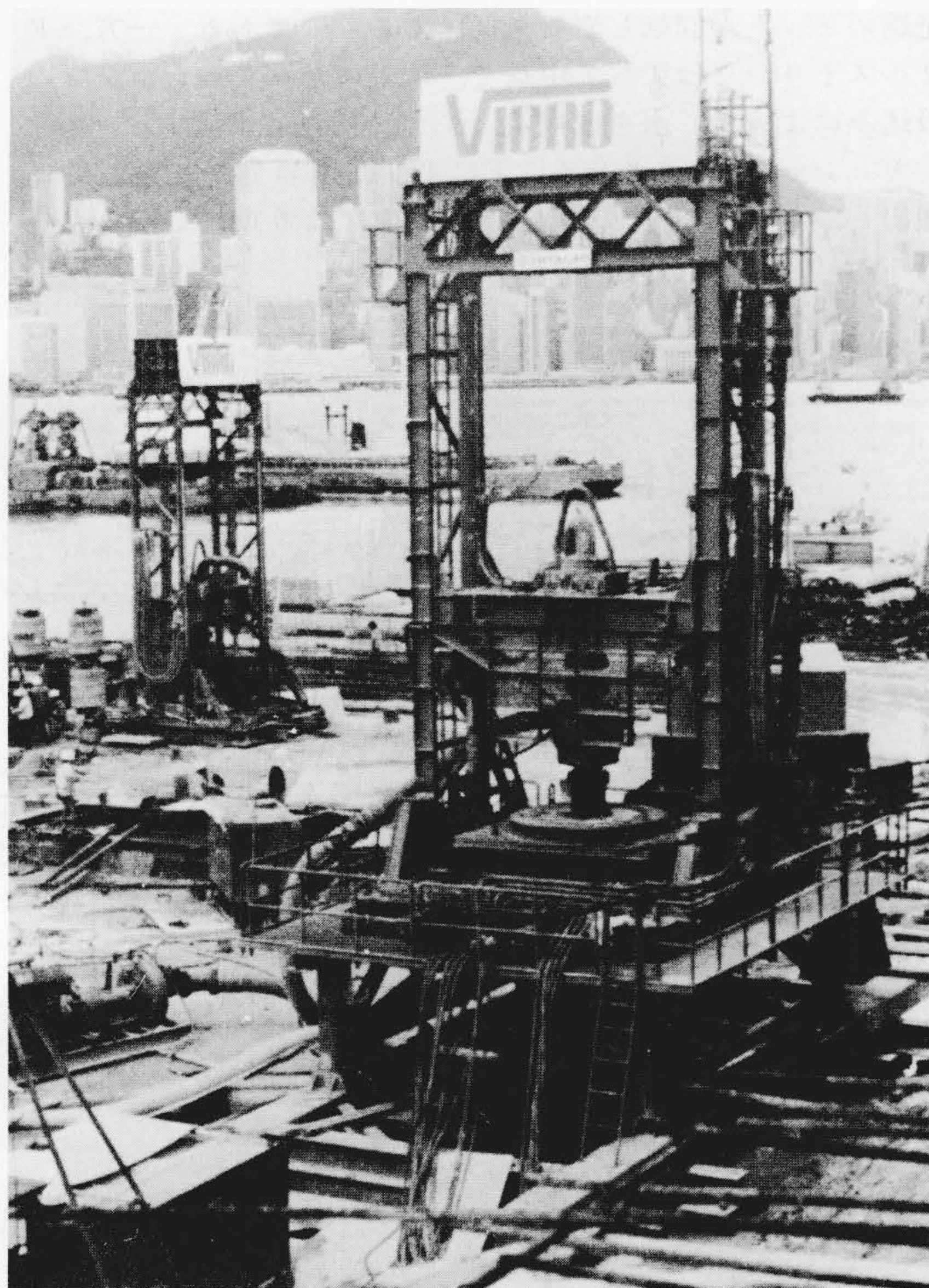
図1 S500R岩盤掘削機の外観 ケリースラスタとロータリテーブルとでドリルストリングを支持している。
