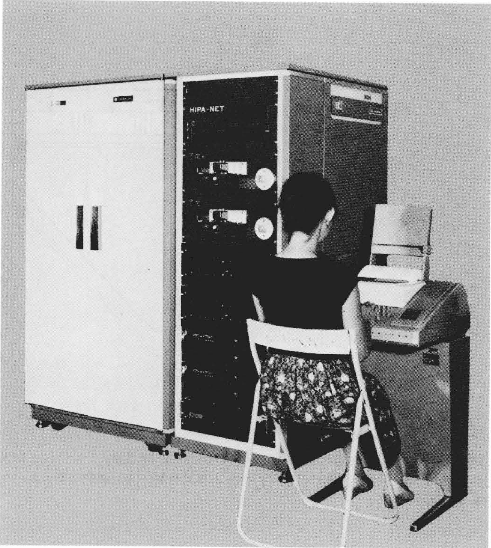
図5 網管理センタの装置構成 網管理センタは、パケット交換局を構成するハードウェア(写真左)に網管理用のI/O筐体(写真右)を付加したものである。
