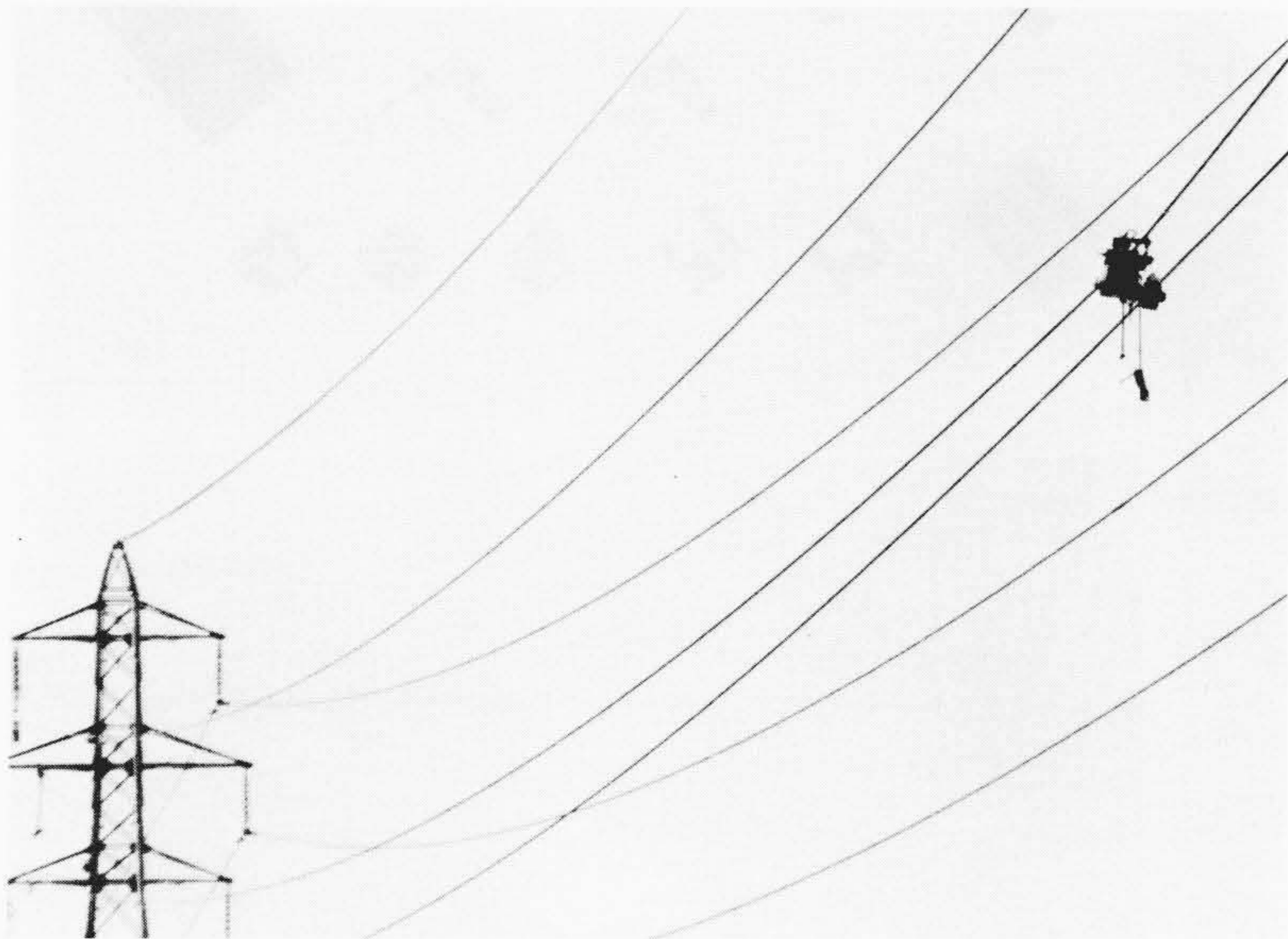
図2 走行ロールによる弛度抑制の状況
