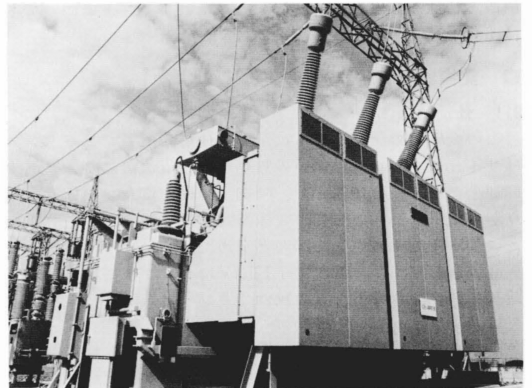
図3 変換用変圧器の外観 低騒音構造である。
