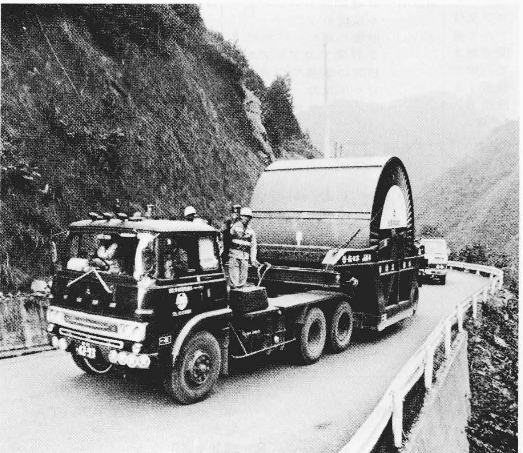
図4 ドラム吊り式トレーラによる輸送 トレーラは、ドラムを積載したまま直接ケーブルの延線が可能な特殊構造となっている。
