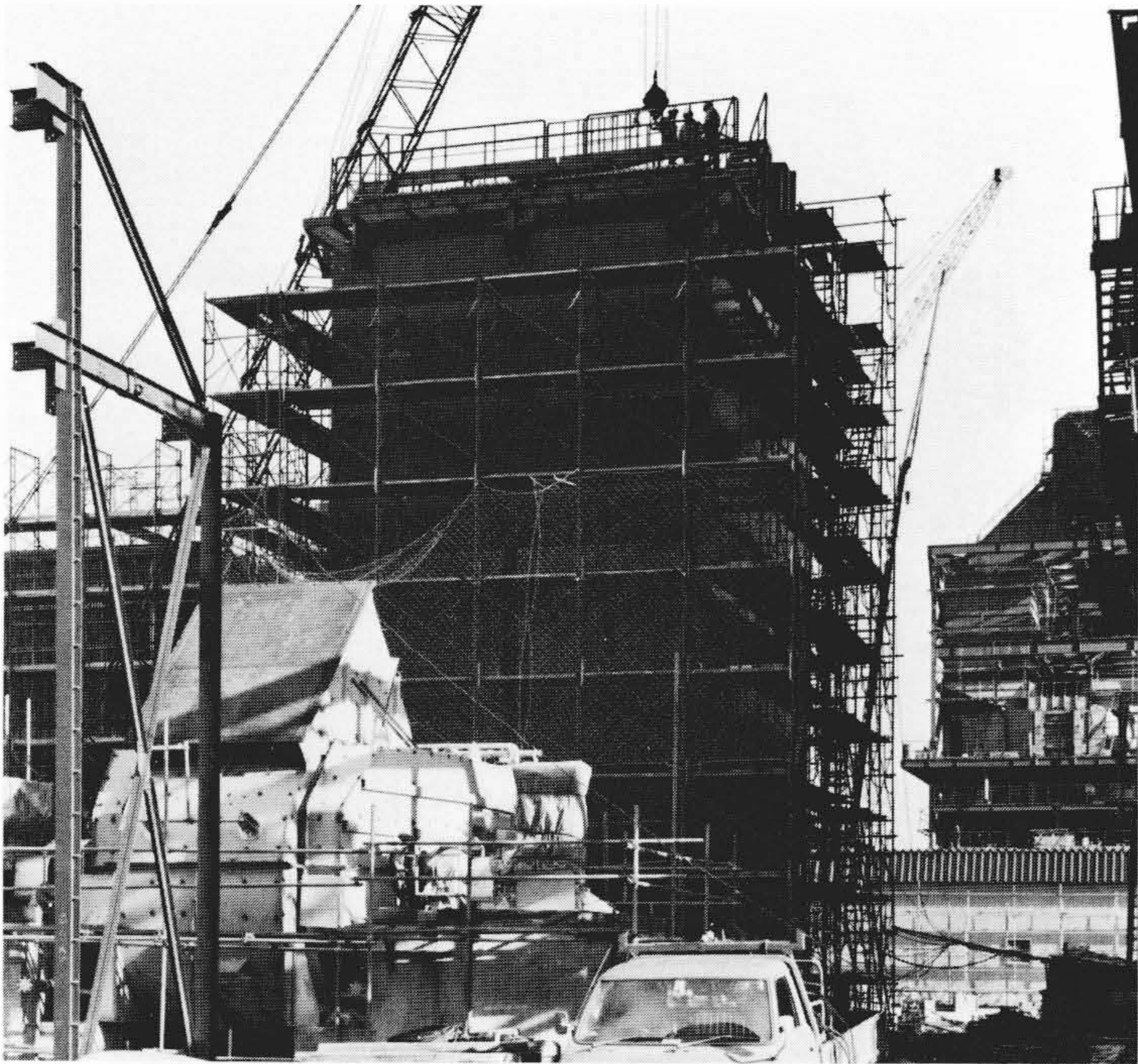
図15 北海道電力株式会社苫東厚真発電所1号機納め排煙脱硝装置(建設中)
