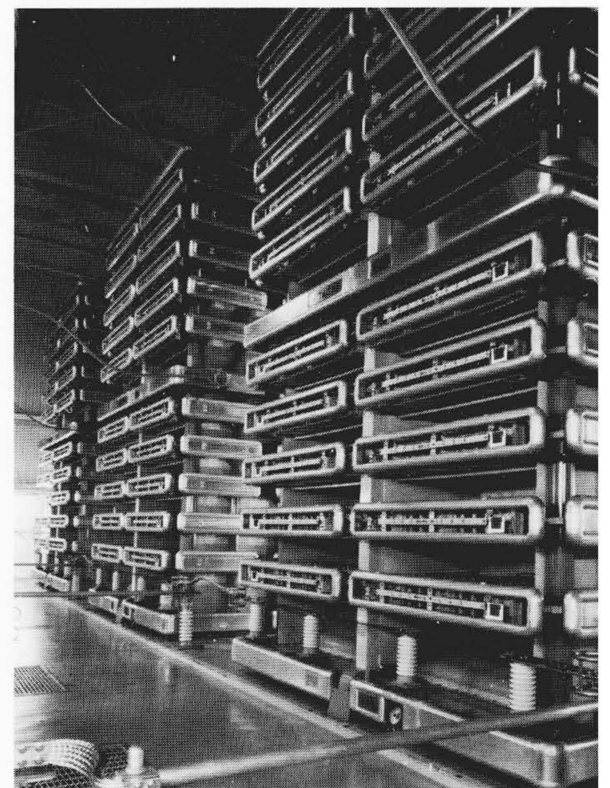
図23 空気絶縁風冷式サイリスタバルブ
