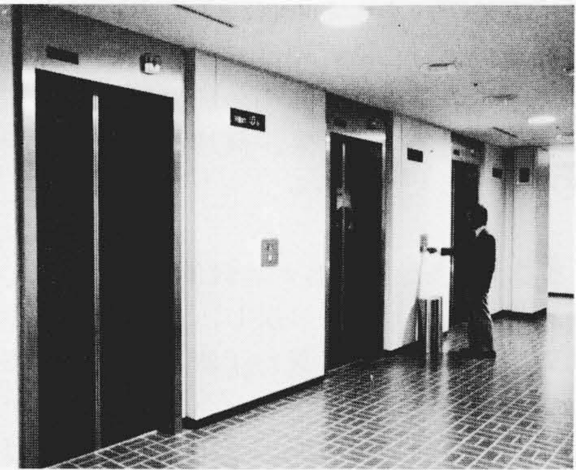
(b) 乗客がホール呼びを登録すると、即時にサービス予約灯を点灯し、予約チャイムを鳴らしてサービスエレベーターを案内表示する。
