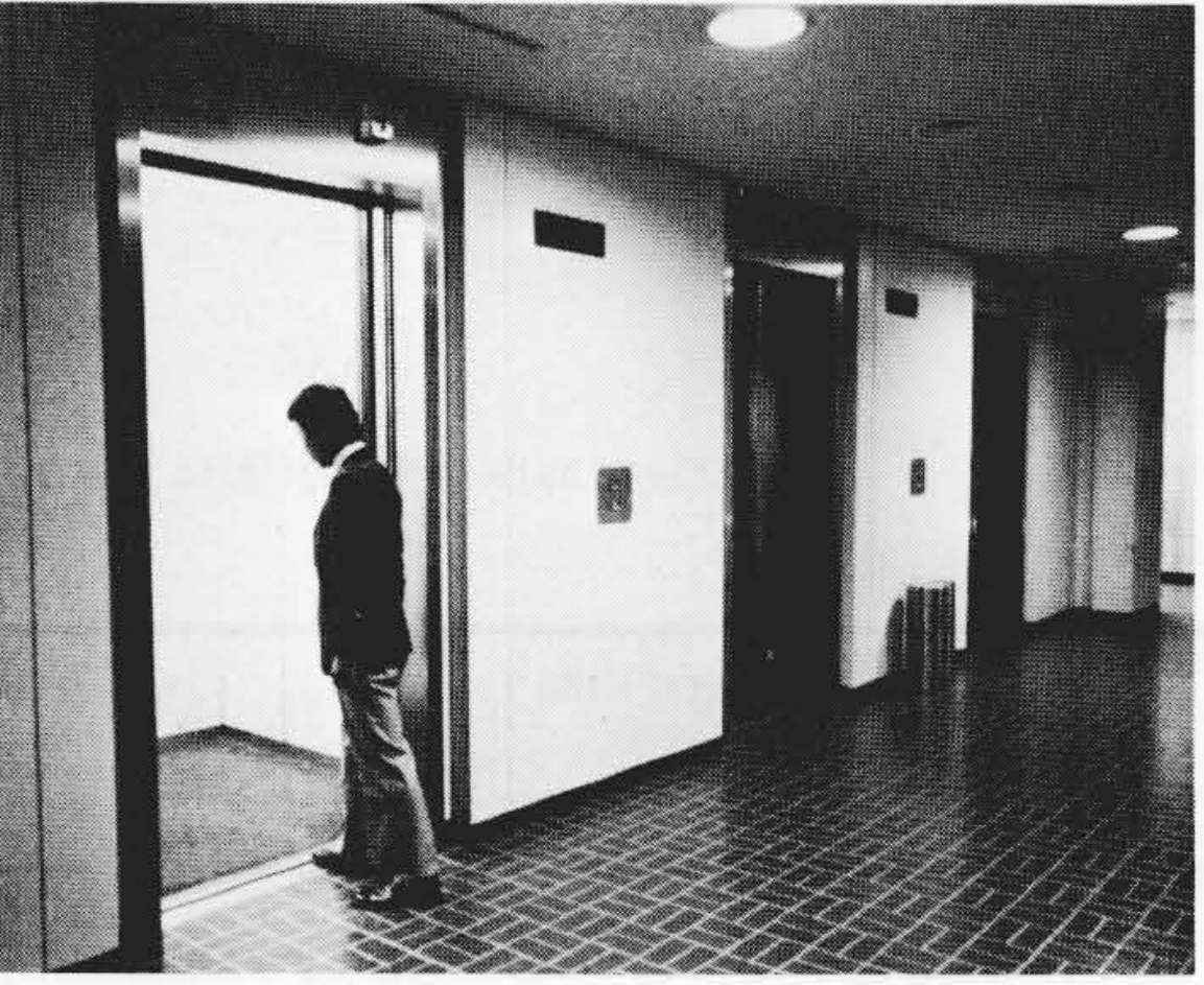
図5 サービス予約灯方式 ホール呼びが登録されると、即時にサービス予約灯を点灯し、予約チャイムを鳴らして待ち客にサービスエレベーターを案内表示する。
