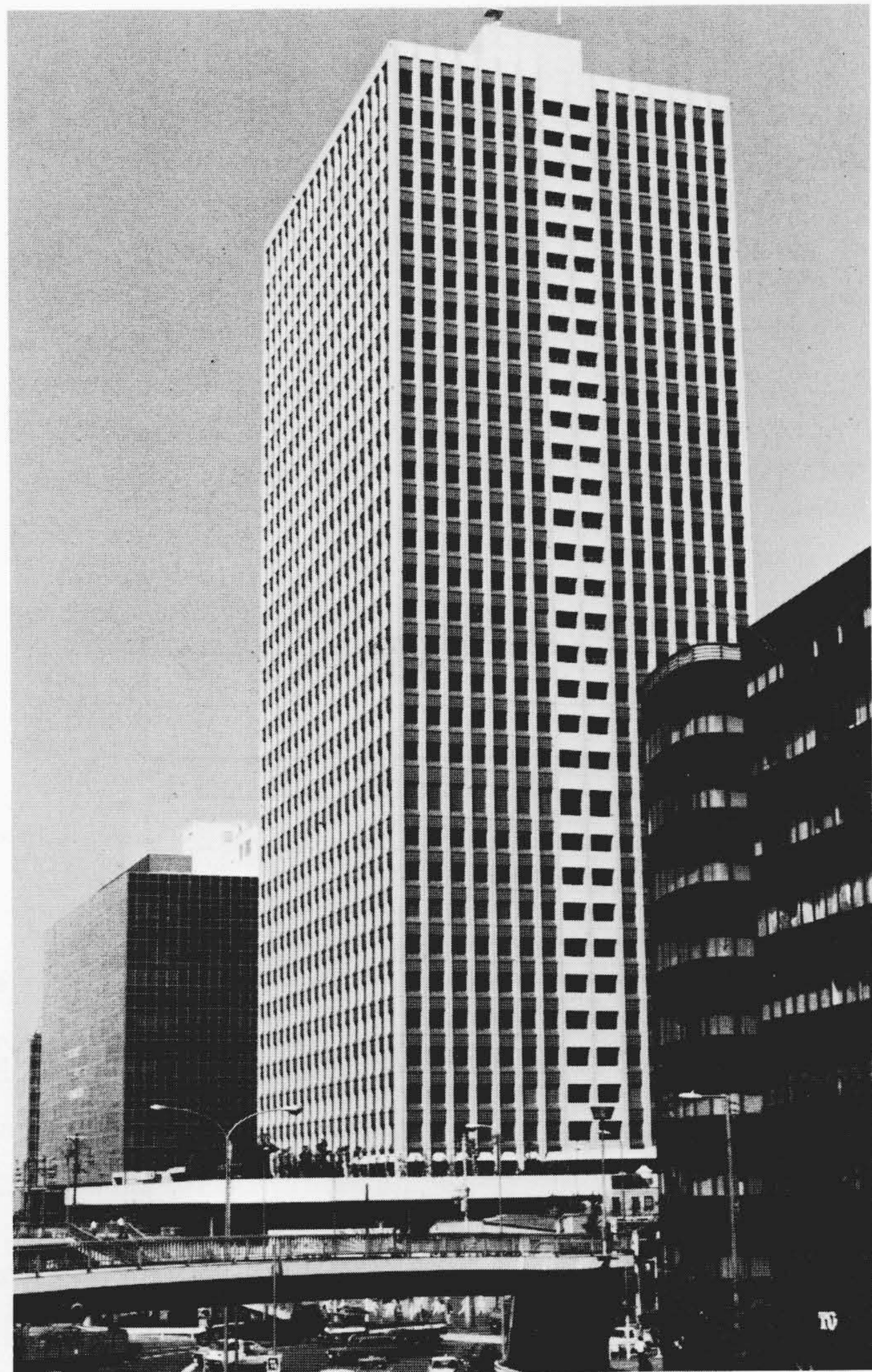
図1 大阪駅前第三ビル 本ビルにエレベーター群管理システム“CIP-3800”の1号機を納入した。
