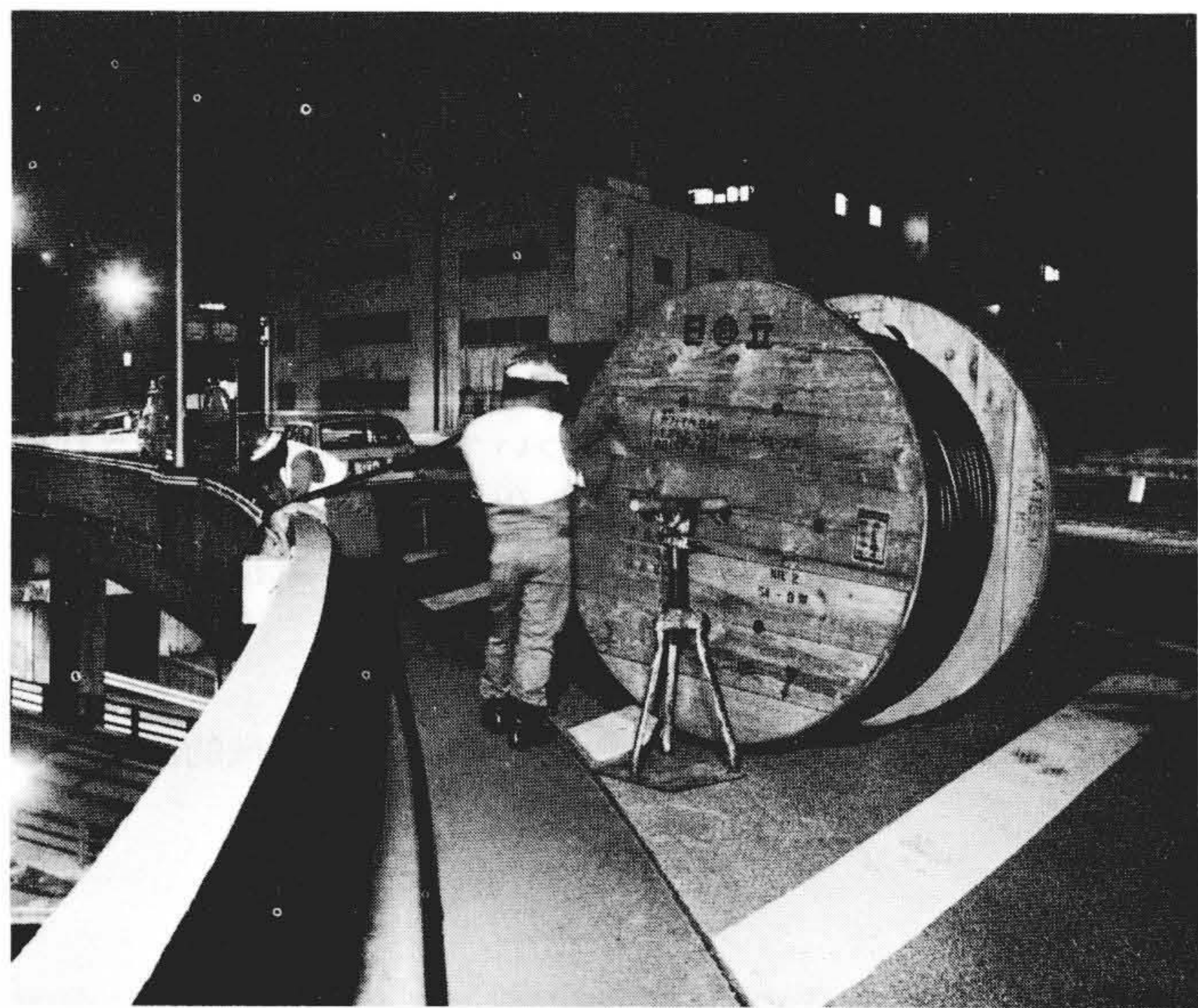
図6 ケーブルの布設工事状況 工事は同サイズの通信ケーブルと同等の条件で行なわれた。
