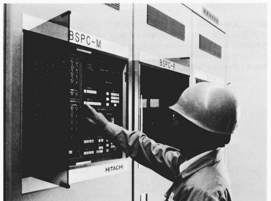
図9 装置の整定表示パネル 本システムは、遠方電気所の端末装置を除けば、主制御装置3架、後備制御装置2架、記録装置1架及び電流合成変流器盤1架の7架で構成している。
