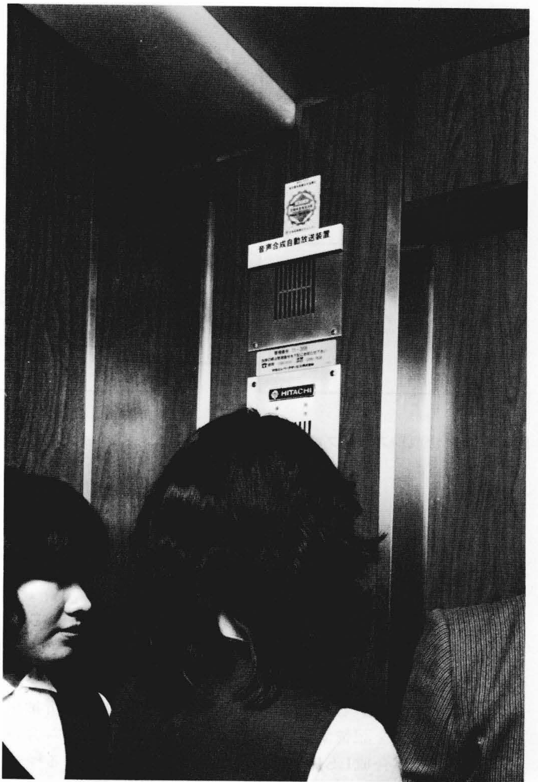
図7 音声合成自動放送装置を設けたエレベーター 都内のビルに納入したもので、エレベーターの運転案内放送などにより利用者から好評を得ている。
