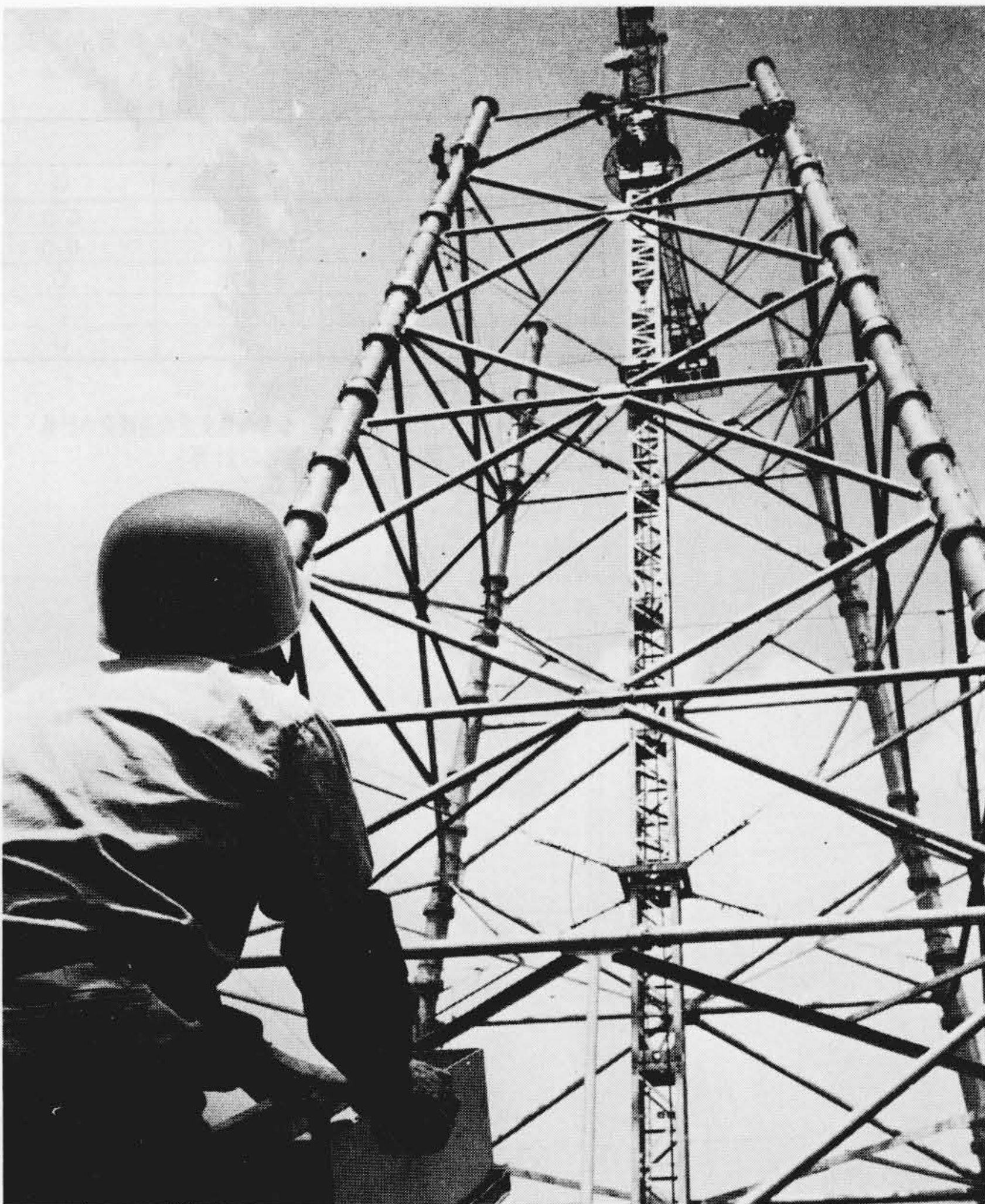
図3 CT 65の地上操作盤 鉄塔上(又は機上)にも操作盤があり、切換えでどちらからでも遠隔操作が行なえる。
