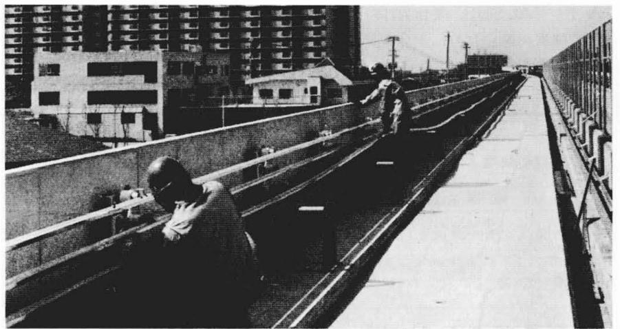
図9 “ALSUS”複合剛体トロリの布設作業状況 10m定尺トロリは、溶接で接続した後でも軽量なため、人力で取扱いができ、施工性が優れている。
