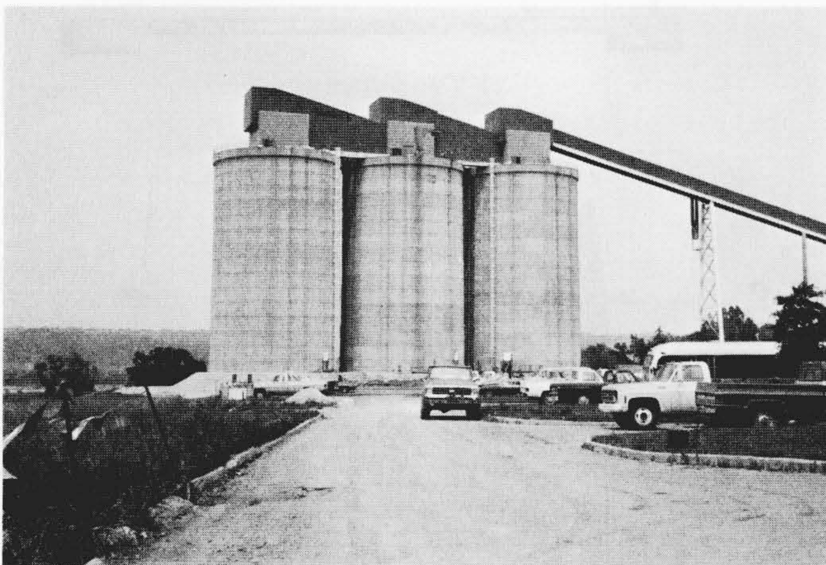
図1 発電所に設置されているサイロ 米国石炭火力発電所に設置されているサイロの一例を示すもので、容量は1基当たり15,000sh tnである。
