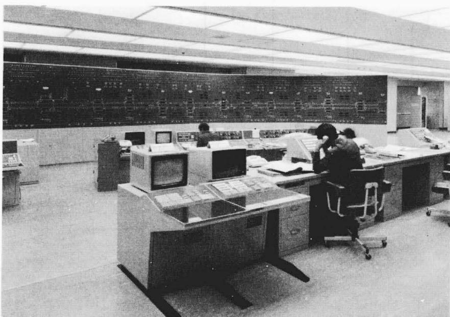
図1 実車試験中の運転指令室 指令室はキャラクタディスプレイ、グラフィックディスプレイを使用して、コンピュータと会話する。
