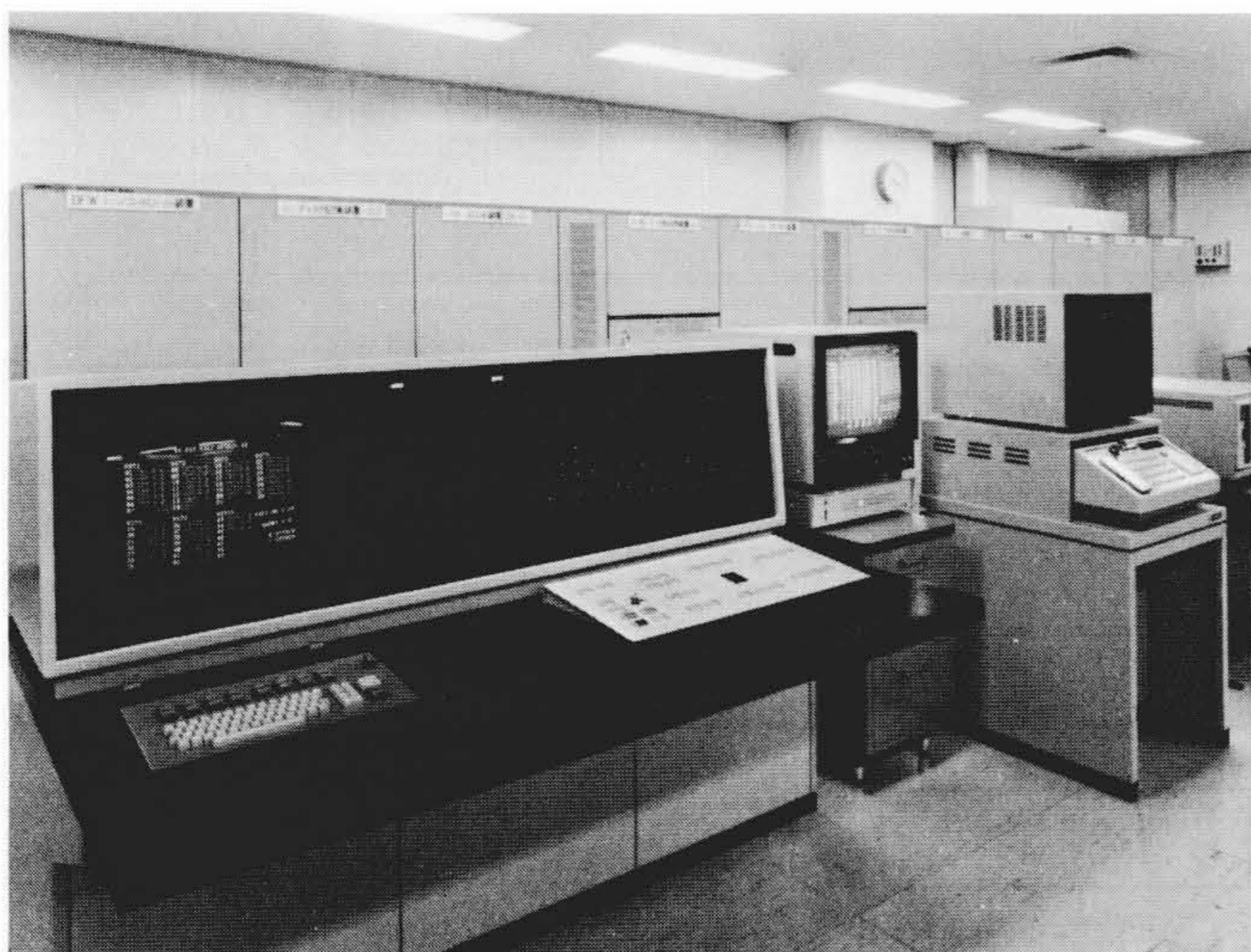
図6 システム監視操作卓 全機器の状態が監視でき、計算機M/DISCなどの二重化機器の切替操作ができる。
