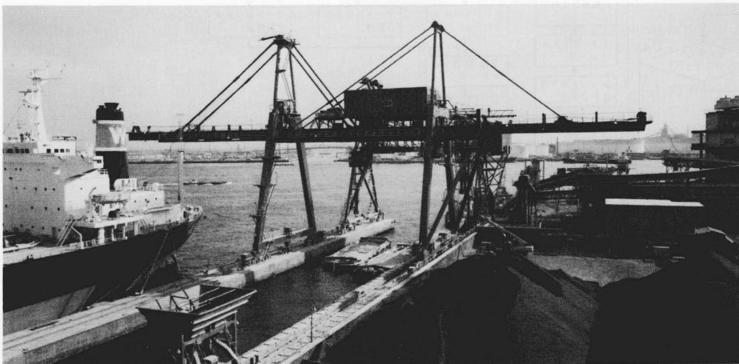
図1 10tグラブバケット付橋形クレーン 東洋埠頭株式会社納めローブトオリ式橋形アンローダで、本船からヤードへの陸揚げ及びバージ船への直接積み替えができる。
