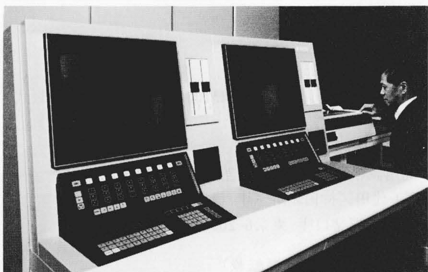
図1 オペレータコンソールの外観
