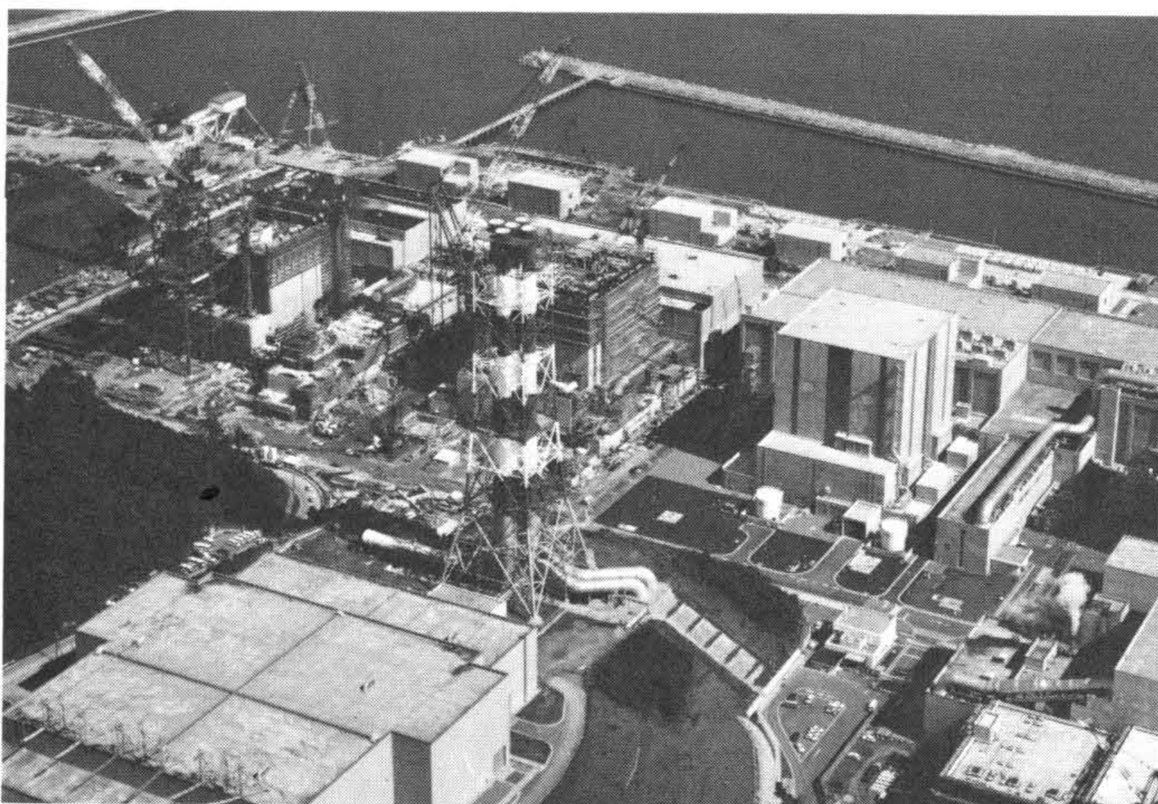
図1 東京電力株式会社福島第二原子力発電所2号機(福島第二・2号機)(右端)の全容 我が国改良標準化ベースプラントとして昭和54年2月着工し、59年2月3日運開した。改良型原子炉格納容器をはじめ、日立製作所の自主技術が多く採用され、電気出力1,100MW BWRとしての建設工程を最短記録で完成した。
