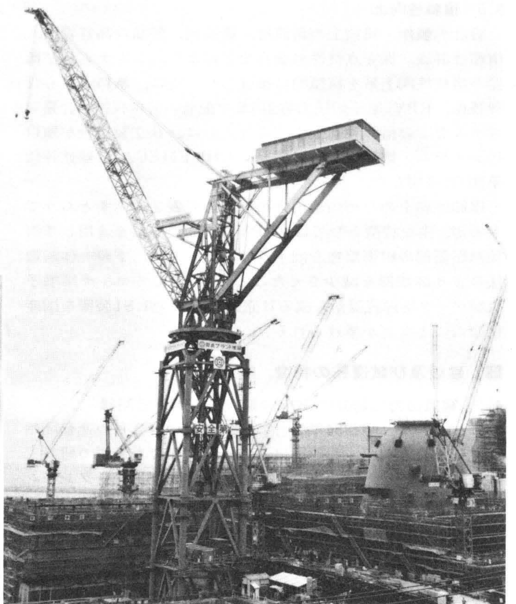
図7 130t×50mジブクレーンによる建設状況 図に示す使用済み燃料プールの大パネルプレハブ化構造のほか、原子炉建屋天井クレーン・燃料交換台車などの大型機器一体つり込みに活躍し、建設工法の改善ができた。
