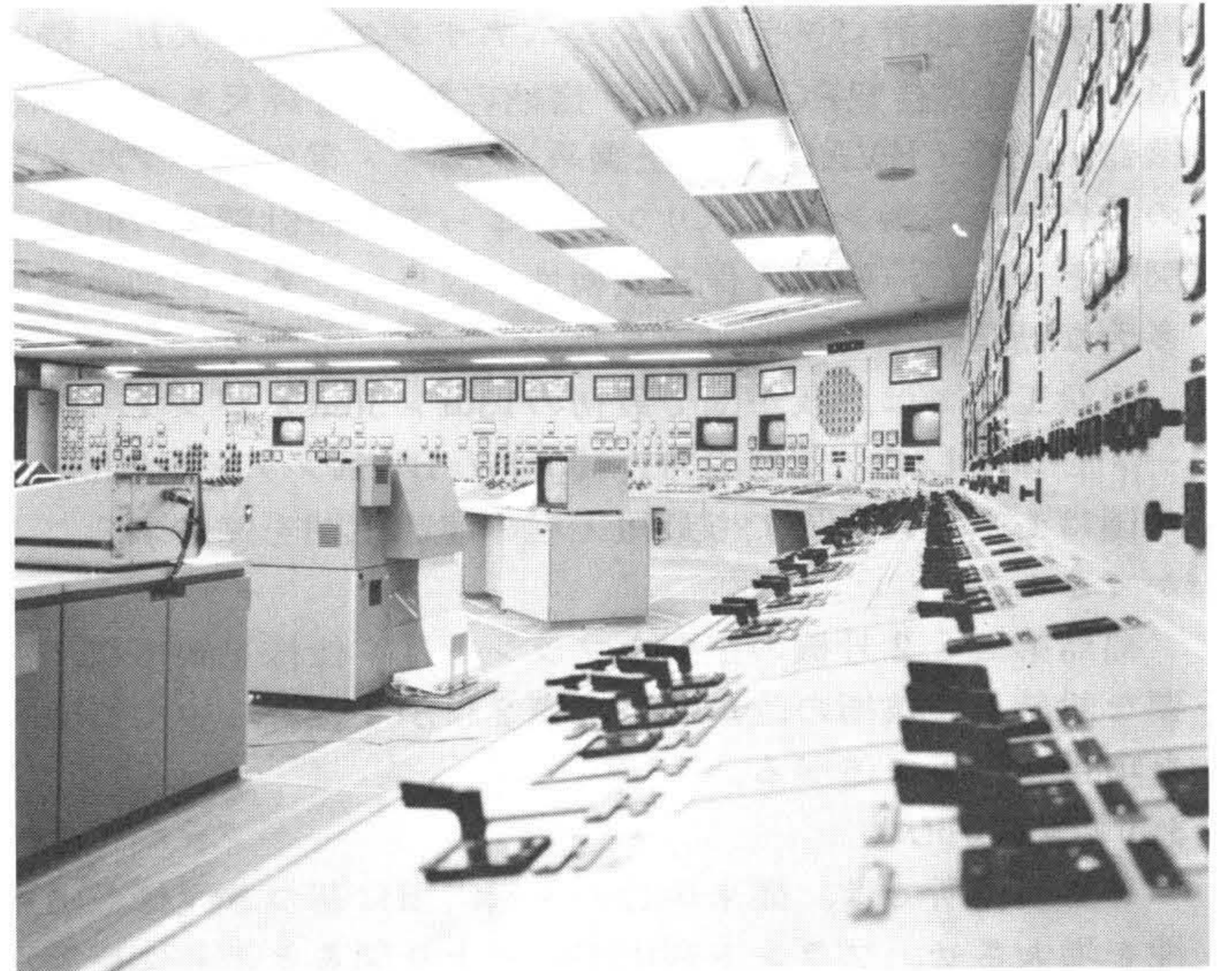
図5 CRT付制御盤とHIDIC 80E計算機などによる運転性が向上した中央制御室配置 CRT付制御盤とHIDIC 80E計算機によって、運転監視性と高信頼化が図られている。
