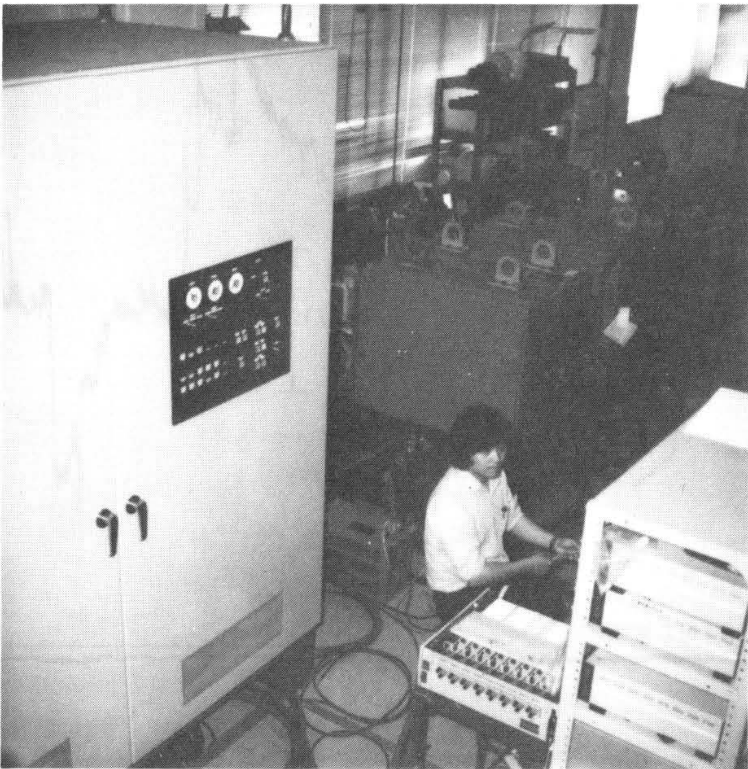
図8 試作機試験状況 文部省高エネルギー物理学研究所で実負荷と組み合わせ、試作機の動特性の評価試験を実施した。
