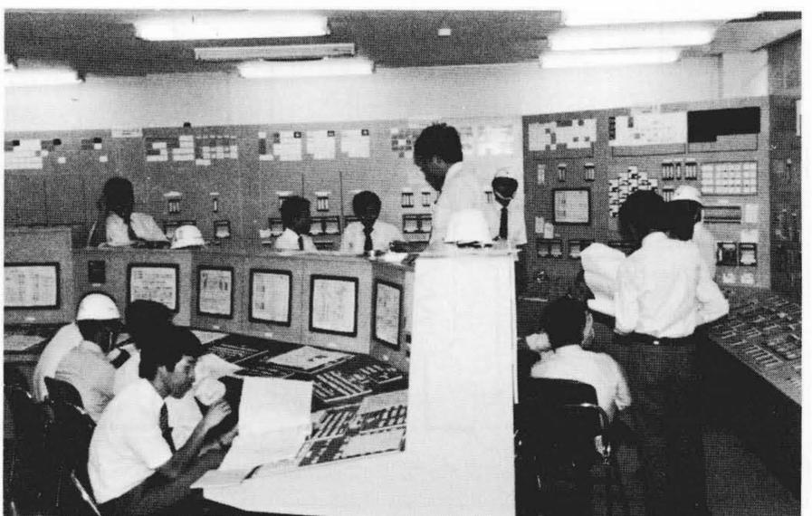
図3 モックアップ盤を用いた模擬操作検討状況 中央監視盤、中央制御盤を模擬したモックアップ盤を用い、運転員の監視操作性などについて人間工学的検討を加え、盤の形態、配置、盤面設計などへ反映している。
