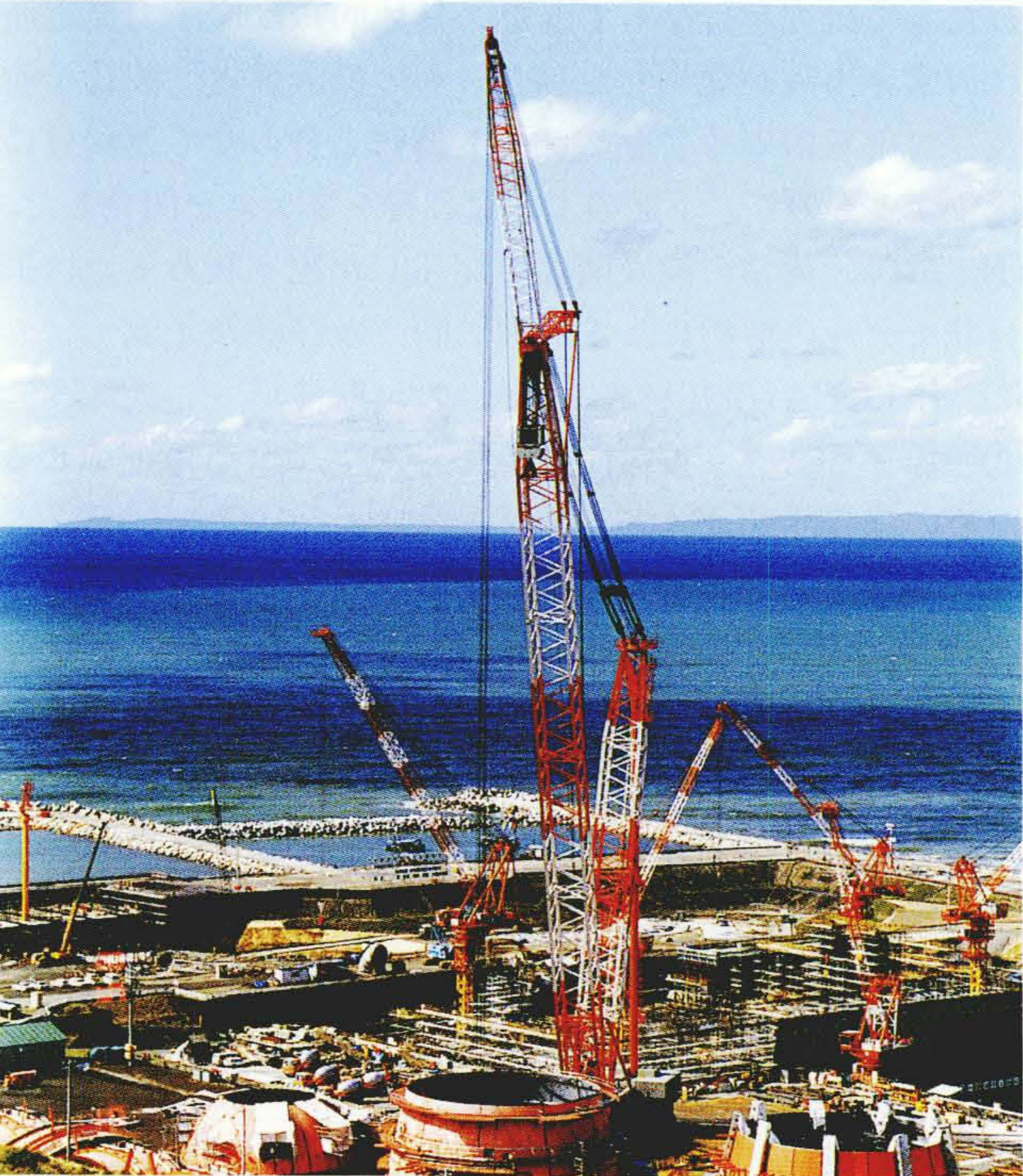
大型移動式クレーンによる原子炉格納容器の地組
