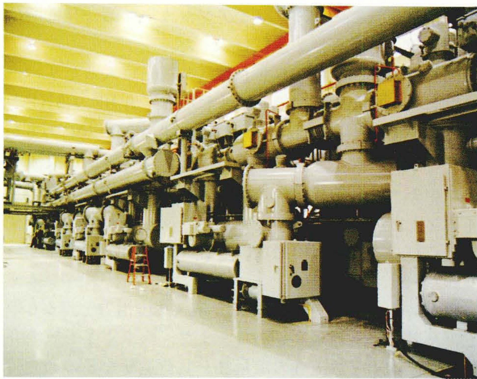
BPA納め550kVガス絶縁開閉装置(1 \frac{1}{2} CB方式)
