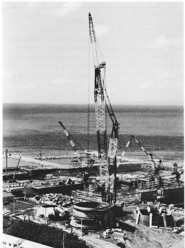
図8 クローラクレーンの活用 ABWR建設工程は岩盤検査から運開まで48箇月が標準であるが, クローラクレーンの導入により建設工事のフレキシビリティが著しく増大するので, 45箇月以下の工程も可能になる。
