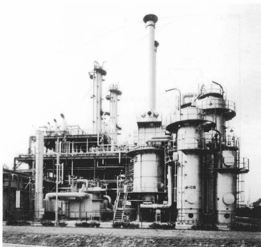
図9 COG-SNG製造プラントの外観 前方の右側の反応塔が、COG精製工程である。
