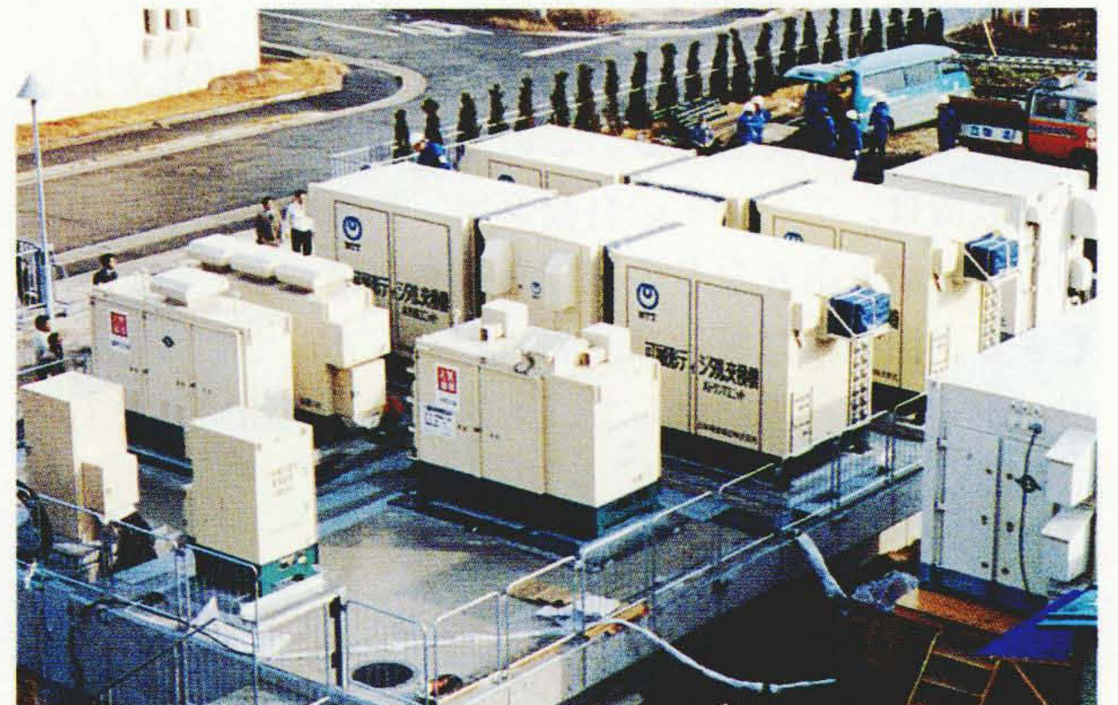
非常用可搬形デジタル交換装置
