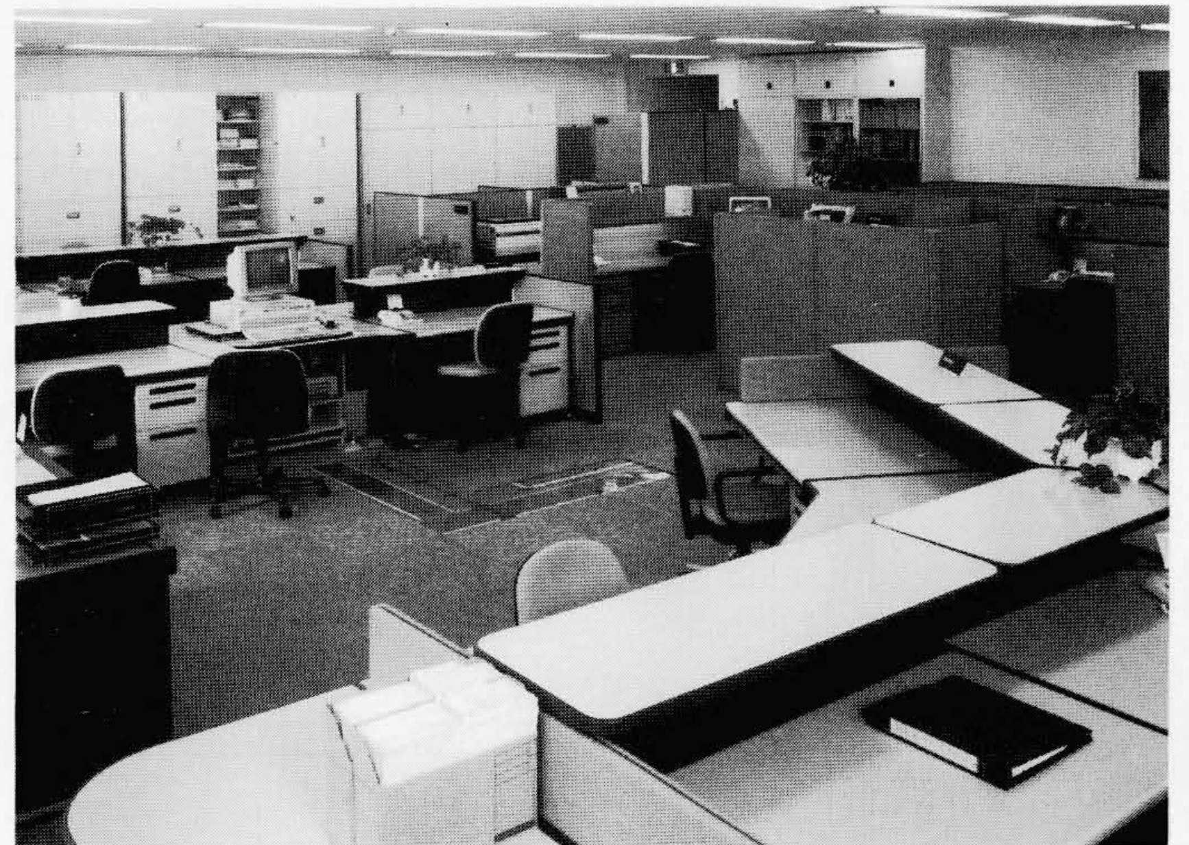
図10 アンダーカーペット配線システム適用オフィス状況 床面に露出した配線は皆無となり優れたオフィス環境となり、しかも必要によりどこにでも配線できる。
