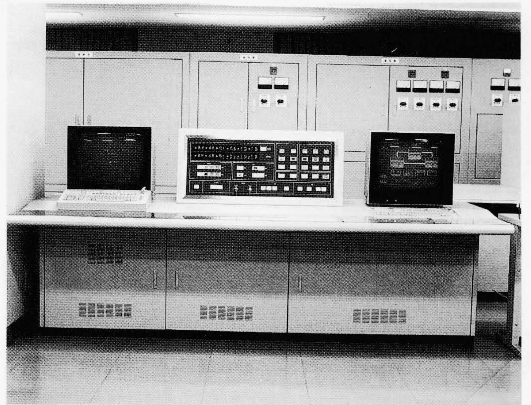
図8 システムコンソール 盤面表示は必要最小限にし、CRT主体のインテリジェント化を図った。
