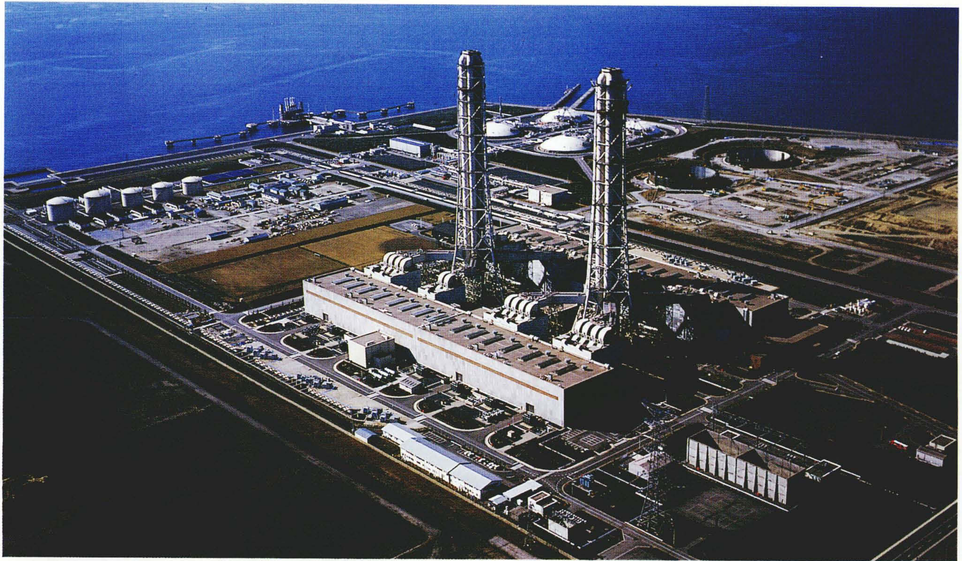
営業運転に入った東京電力株式会社富津火力発電所の全景(1・2号系列合計2,000 MW)
