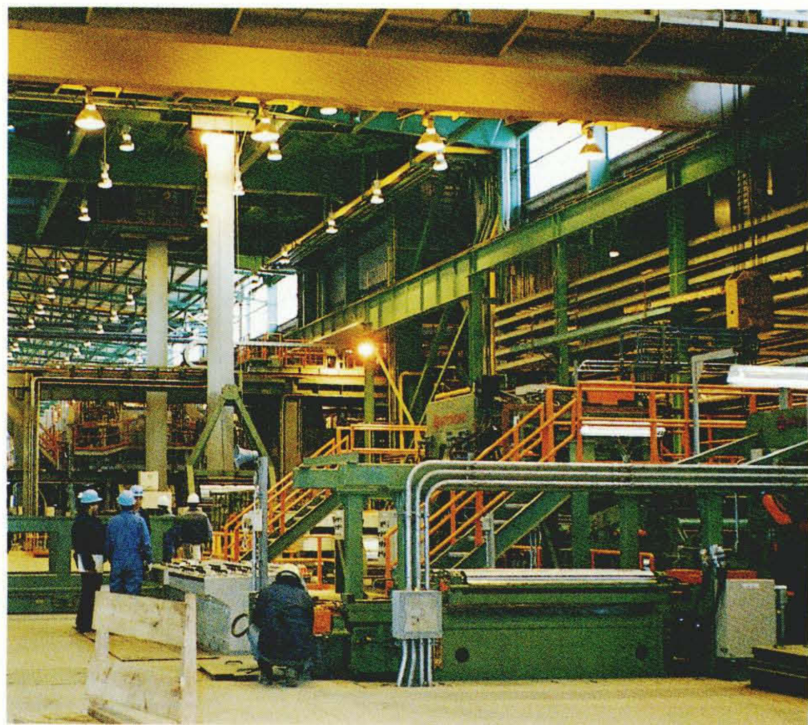
高品質めっき設備AGL中心部
