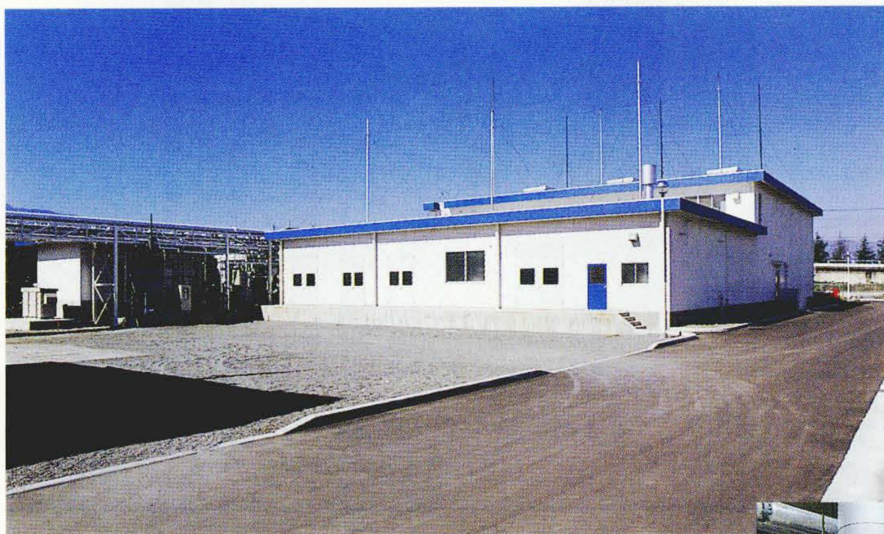
パイオニアビデオ株式会社田富工場エネルギーセンター
