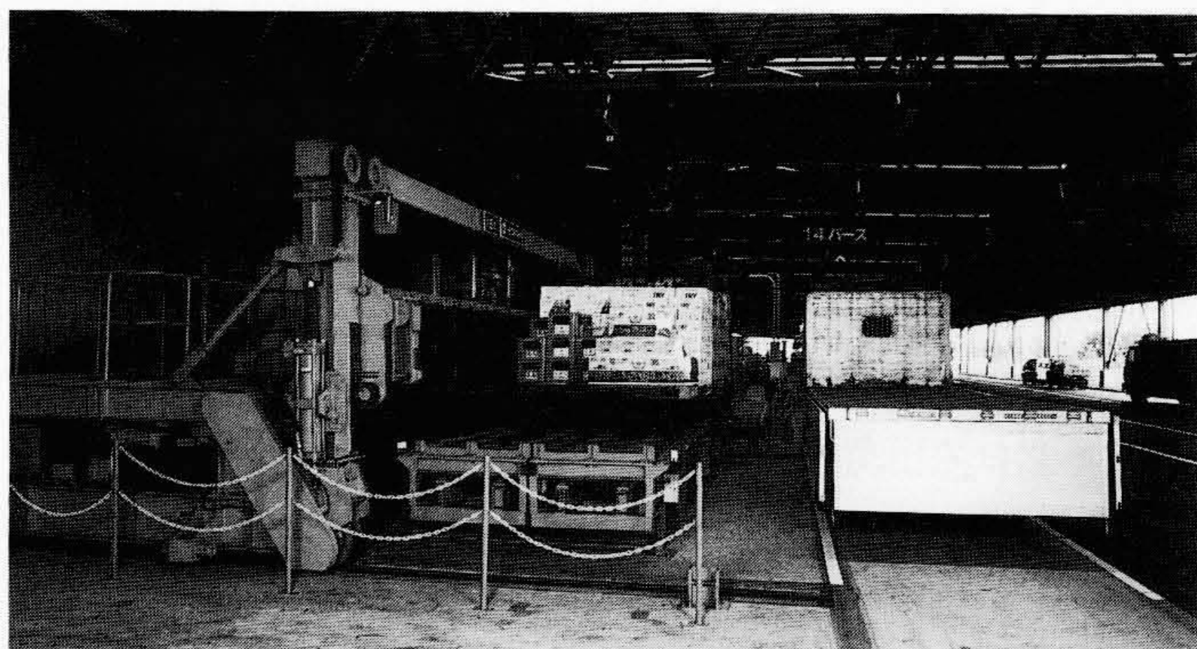
図10 トラック積込機 1ストロークで18パレット(大瓶432ケース: 8,640本)を積み込むことができる。
