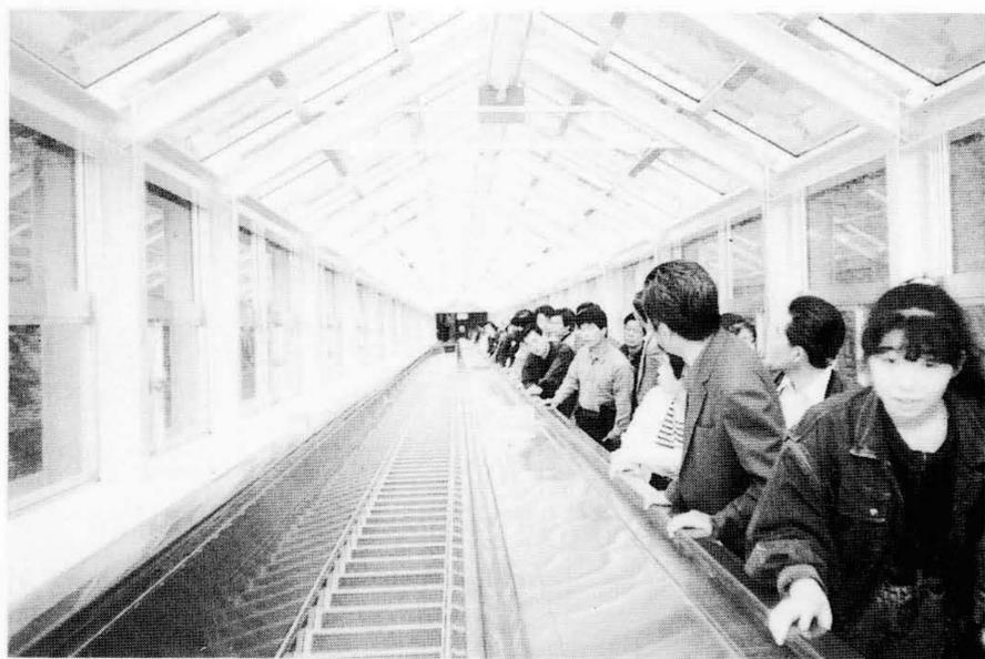
図6 性能試験の状況 180人余りを乗せた全負荷状態で、制動テストほかさまざまな性能試験を実施した。
