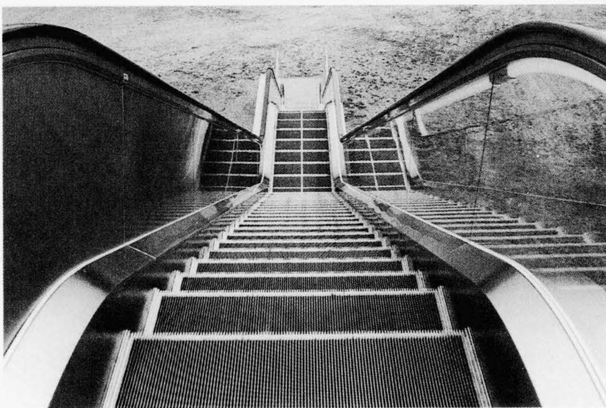
図9 乗客が実際に下を見たときの状態 全揚程10 mの中間に水平部を設けた例を示す。これにより、下降時の乗客の安心感が増す。
